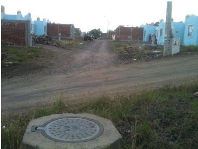
Imagen 3.6. Av. Las Lomas y Calle Resurrección, alcantarillado. Fuente: Propia (2014).
