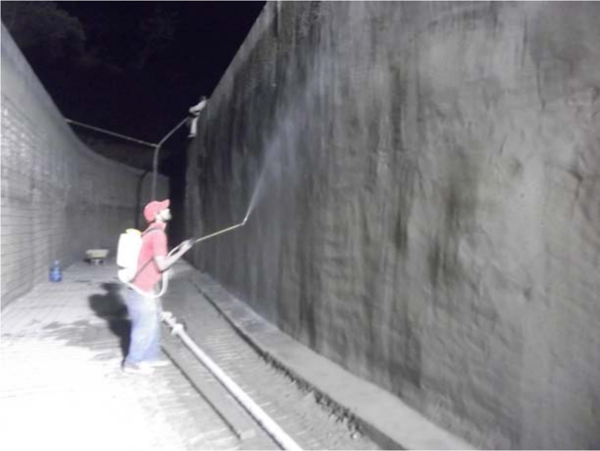
Fotografía 3.5 Colocación de aplicación de aditivo.
