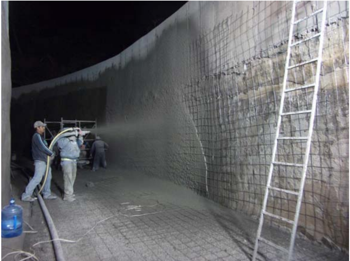
Fotografía 3.3 Colocación de concreto lanzado en malla electrosoldada.
