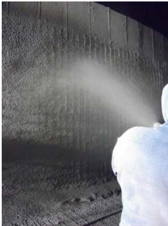
Fotografía 3.1 Colocación de concreto lanzado.
