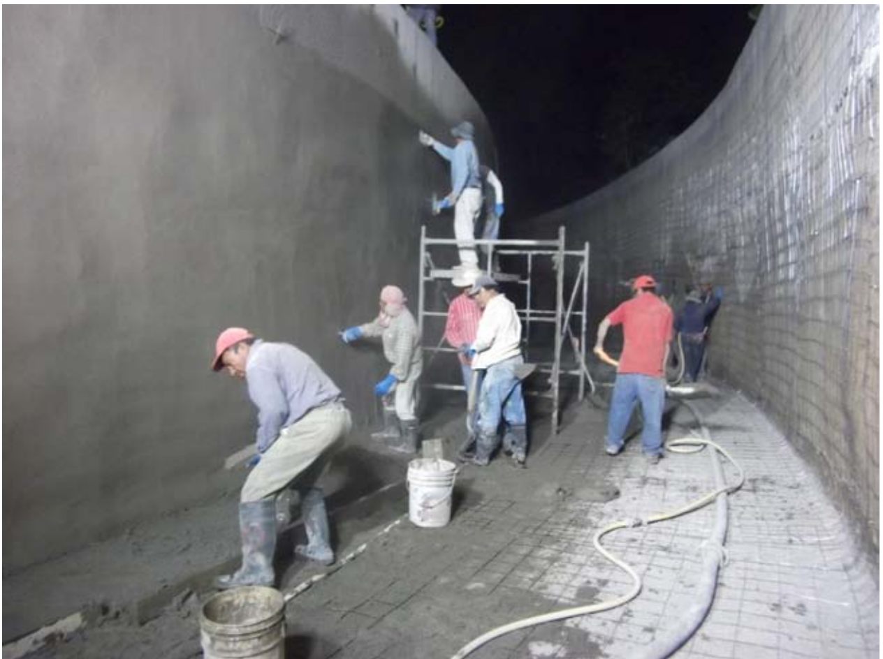
Fotografía 3.4 Trabajos de repellado.
