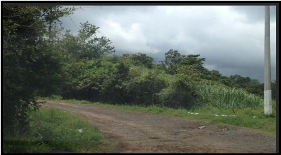
Figura 3.10 Estado actual del camino
