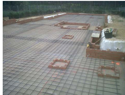
Ejemplos de armados en losas de cimentación
