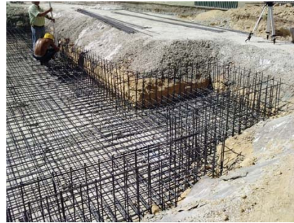
Ejemplos de armados en losas de cimentación
