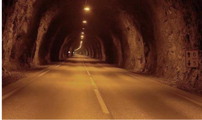
Figura 4.5. Túnel de Gudvanga, Noruega. Longitud de 11,42 km, http://www.fierasdelaingenieria.com/los-tuneles-de-carretera-mas-largos-del-mundo/
