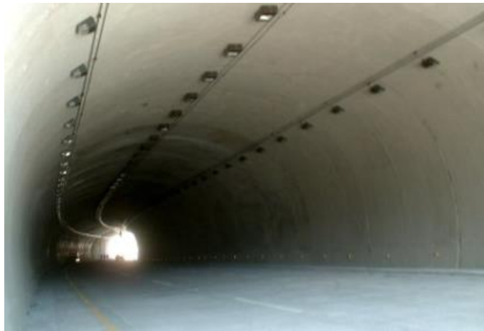
Figura 1.19. Túnel los Chorros, Carretera a Monterrey, México. (Cortesía: M.I. J. Francisco Suárez Fino).
