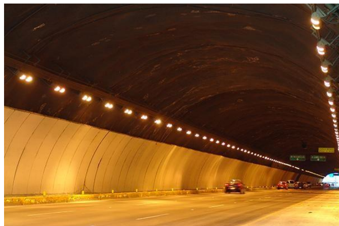
Figura 6.2. Concreto lanzado y revestimiento en hastiales con paneles. Túnel Loma Larga, Monterrey Nuevo León, México, Ref. [28].
