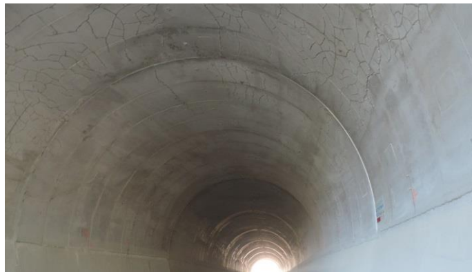
Figura 4.8. Revestimiento de concreto hidráulico, Túnel Interlomas, México.
