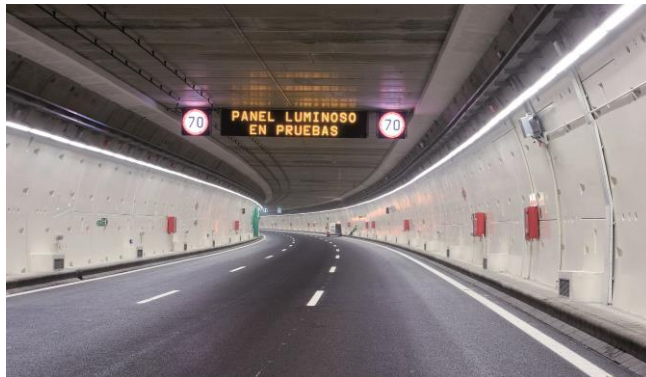
Figura 2.3. Revestimiento de dovelas, túnel carretero M 30, España. Tomada de Alliance, Ref. [26].
