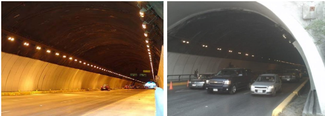
Figura 1.27. Túnel de Loma Larga, Monterrey Nuevo León, México. Ref. [23].
