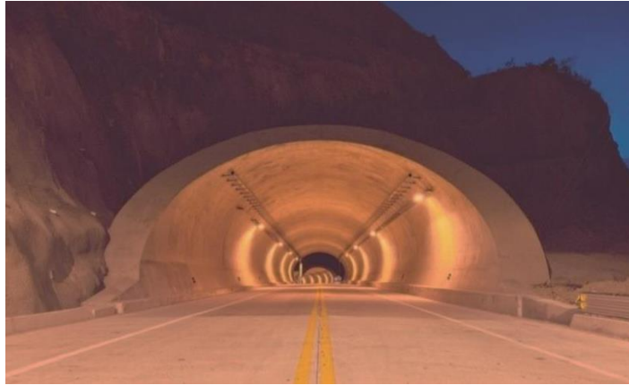
Figura 2.16. Revestimiento de concreto hidráulico en un túnel de la Carretera Durando-Mazatlán, México.
