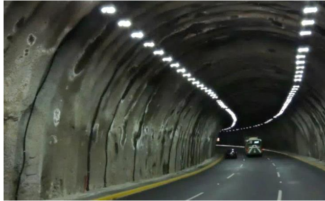
Figura 2.2. Túnel revestido con concreto lanzado, Supervía Poniente, México.
