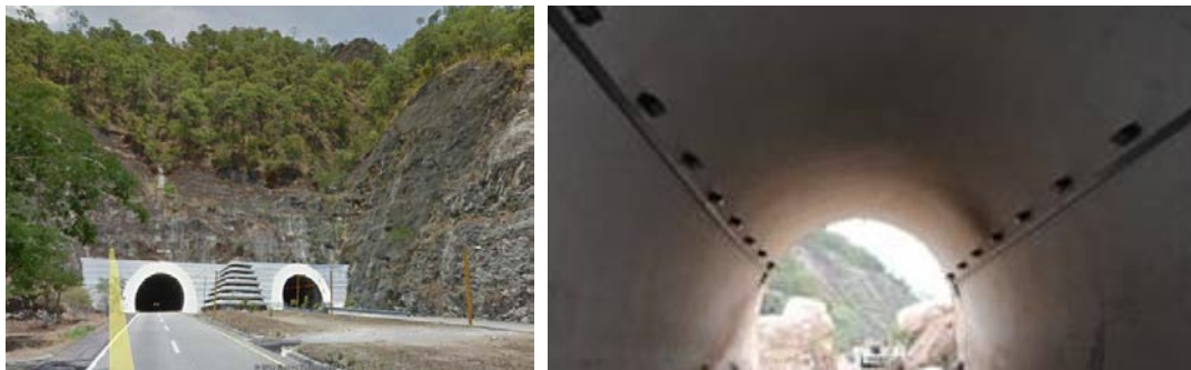
Figura 1.14. Portal e interior del túnel Agua de Obispo. Ref. [14].
