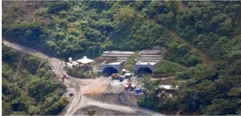
Figura 1.23. Túneles en la Autopista México-Tuxpan, (Cortesía: M.I. J. Francisco Suárez Fino).
