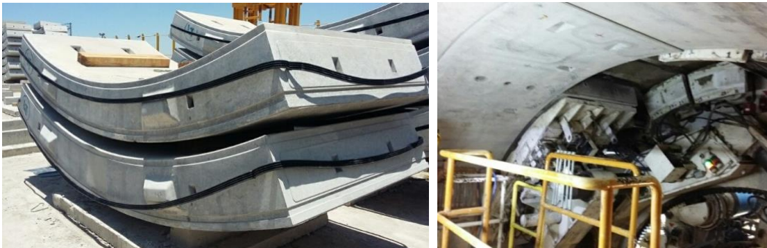
Figura 2.22. Habilitado de dovelas y colocación.
