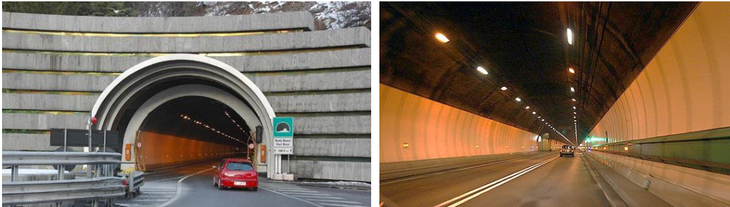
Figura 1.6. Acceso e interior del túnel Mont Blanc, Ref. [7].
