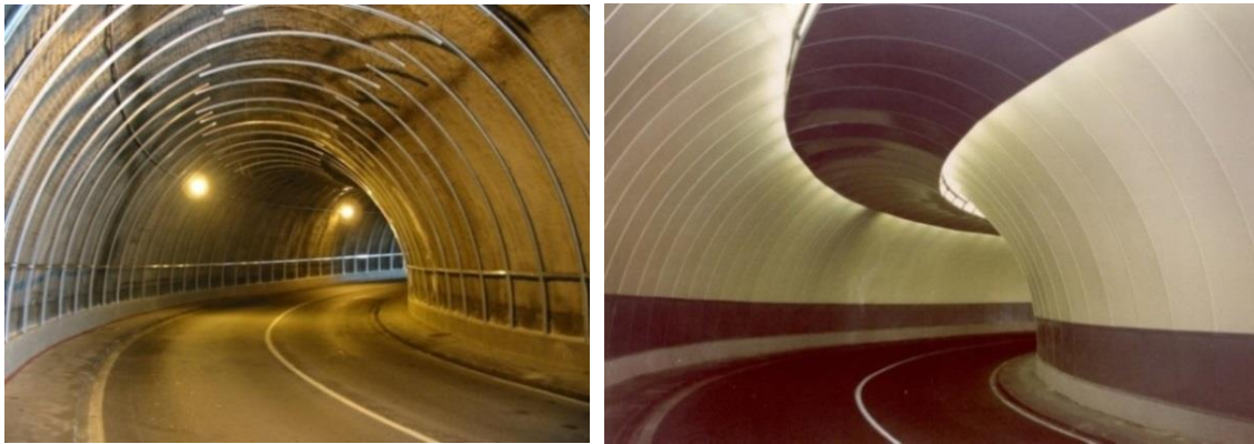
Figura 8.2. Colocación de panel en hastiales y clave de túnel. Tomada de Alliance, Ref. [26].
