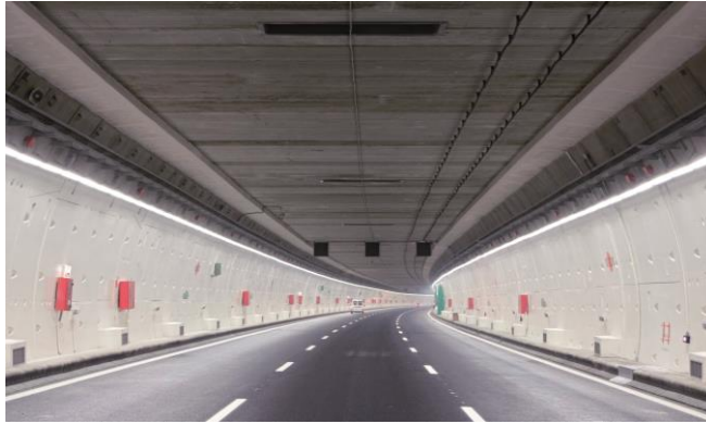
Figura 2.18. Revestimiento de dovelas, túnel carretero M 30, España. Tomada de Alliance, Ref. [26].
