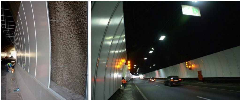
Figura 2.24. Ejemplo de panel vitrificado. Tomada de Alliance, Ref. [26].
