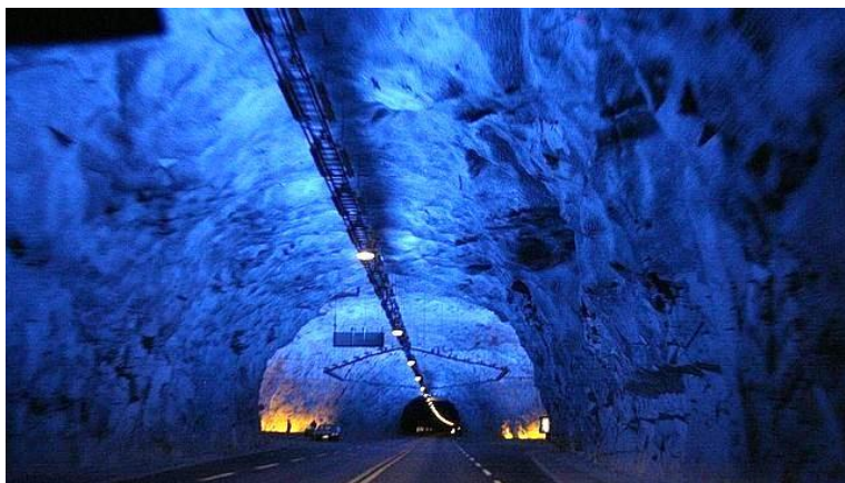
Figura 6.3. Túnel de Laerdal, Noruega. Ref. [29].
