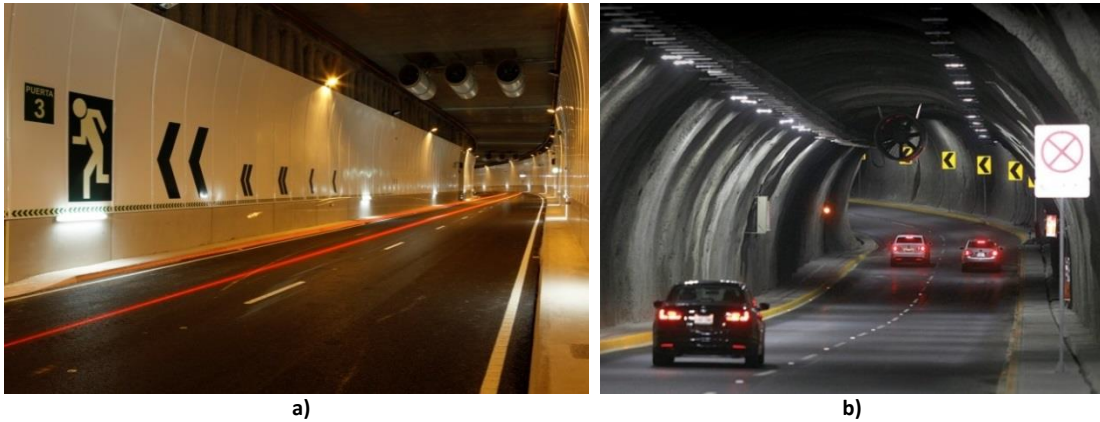
Figura 4.11. a) Revestimiento paneles vitrificados; b) Revestimiento concreto lanzado.
