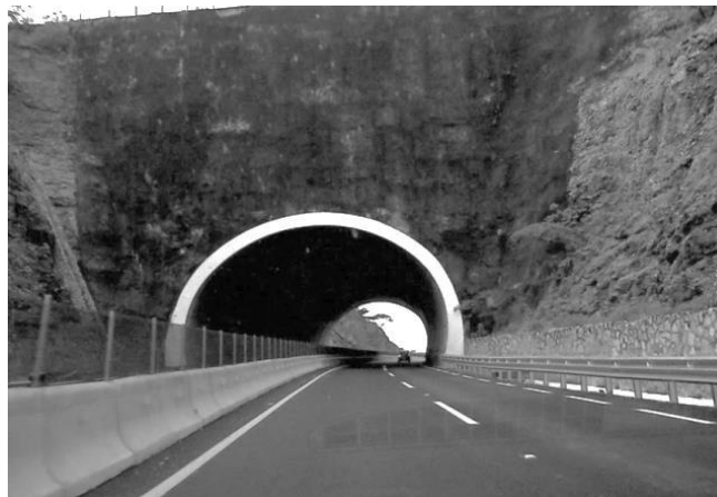
Figura 1.15. Túnel Los Querendes. Ref. [15].
