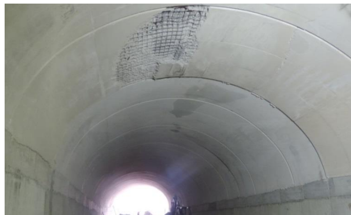
Figura 4.9. Revestimiento de concreto hidráulico, Túnel Interlomas, México.
