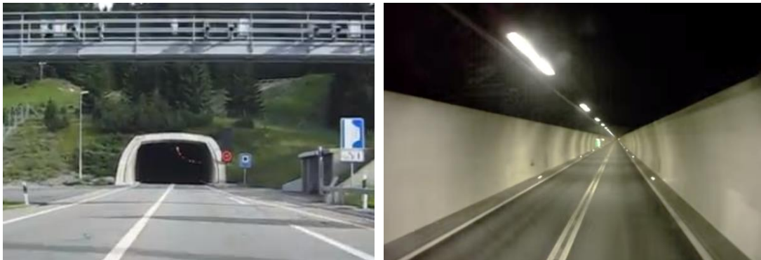
Figura 1.7. Túnel San Bernardino. Ref. [8].
