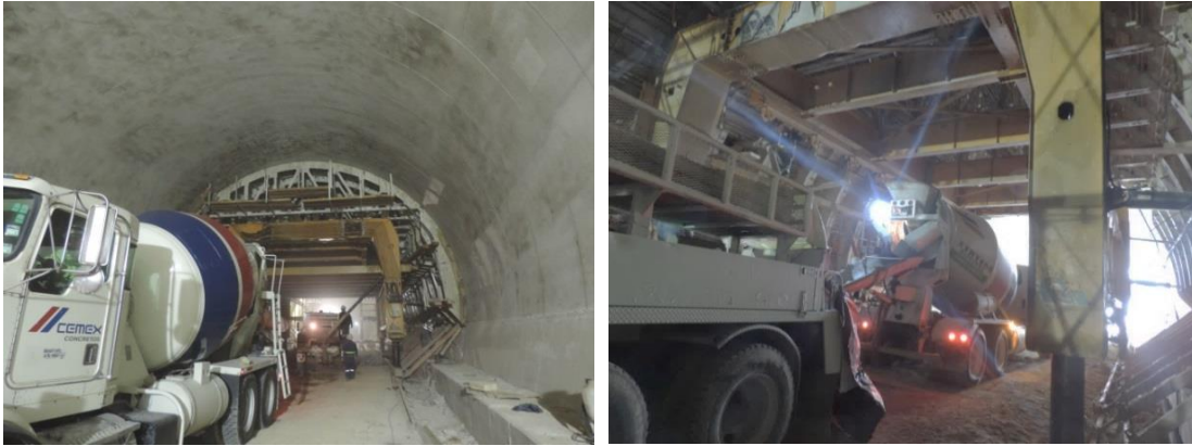
Figura 5.3. Suministro de concreto hasta el frente del colado del revestimiento, Túnel Interlomas, México. (Cortesía Consultec).
