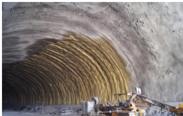
Figura 2.7. Revestimiento de concreto lanzado sobre la geomebrana y malla electrosoldada. Túnel Carretera Toluca-Naucalpan México (Cortesía Consultec).
