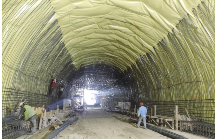
Figura 2.14. Colocación de Acero en hastiales, Túnel Interlomas, México.
