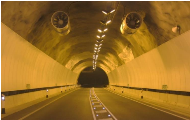
Figura 2.19. Revestimiento con paneles prefabricados. Túnel de Oliana-Coll de Nargo, Lérida España. (Cortesía M.I. J. Francisco Suárez Fino).
