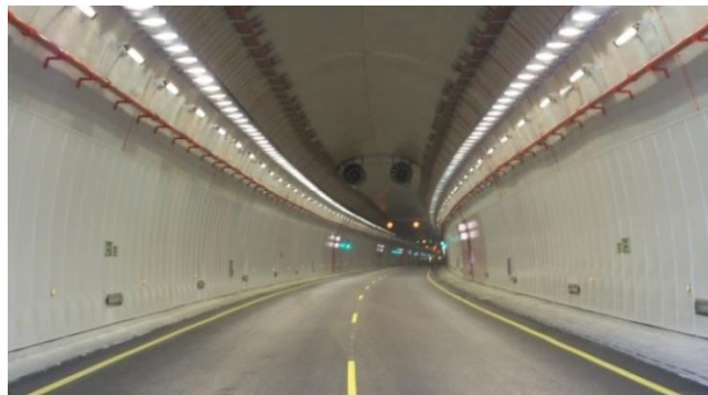
Figura 2.4. Revestimiento a base de paneles prefabricados, proyecto: Túnel Folgoso, Galicia España. Tomada de Alliance, Ref. [26].
