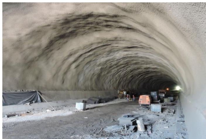
Figura 7.9. Acabado final del revestimiento de concreto lanzado.
