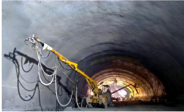
Figura 2.9. Acabado final del revestimiento de concreto lanzado Túnel Carretera Toluca-Naucalpan. (Cortesía Consultec).
