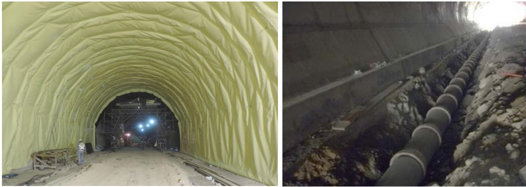
Figura 4.4. Sistema de impermeabilización y drenaje.
