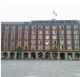
Portal de Mercaderes. Actualmente existe una interpretación de lo que era el portal.
