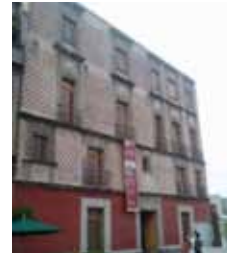
Casa de las Ajaracas. Museo Archivo de fotografía 3 niveles, predomina el macizo sobre el vano.
