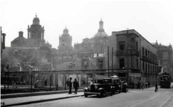
Demolición del Antiguo Seminario Conciliar
