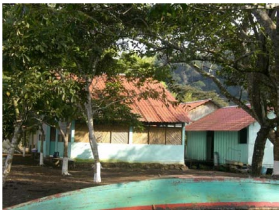
Figura 28. Instalaciones del proyecto Las Margaritas
