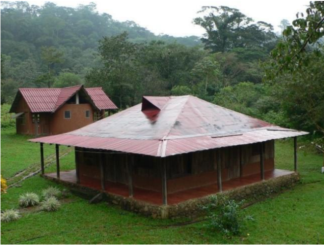
Figura 22. Instalaciones grupo Selva del Marinero
