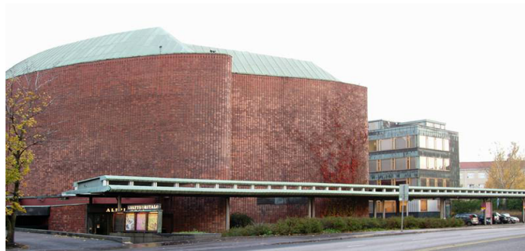
Centro cultural de Alvar Aalto en Helsinki, 1955-1958 Imagen de http://www.ecured.cu/index.php/
