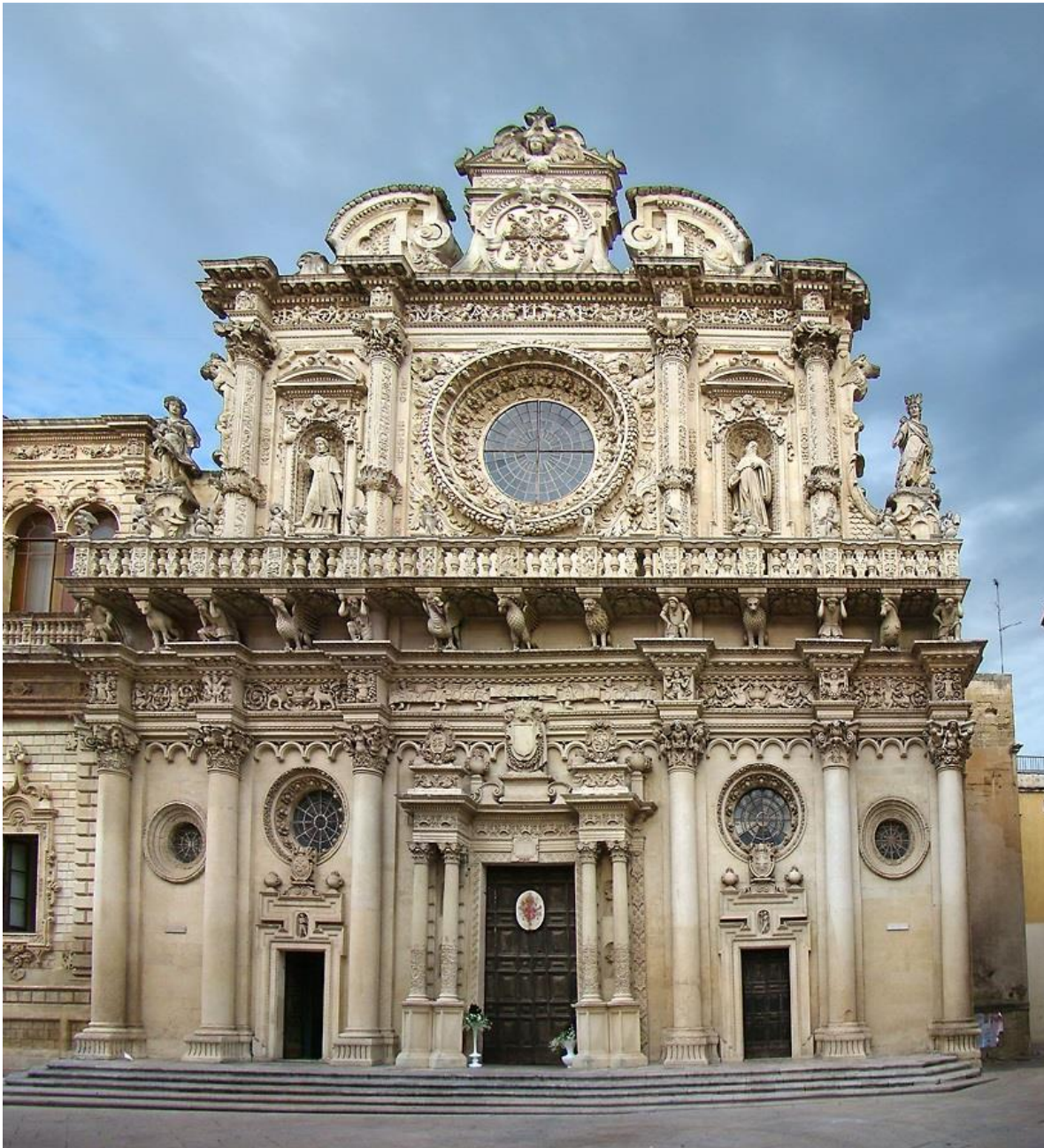
Figura 20. Basilica della Santa Croce en la ciudad de Lecce, se ubica en la región de Puglia, al sur de Italia (Fuente: http://bit.ly/1QyGrcl ).
