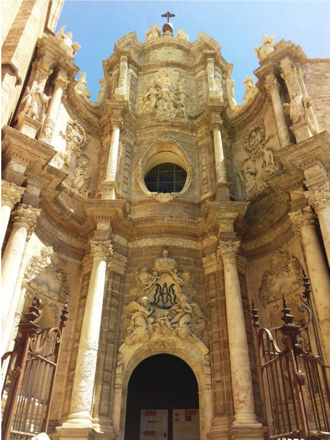
Figura 27. Fachada de una de las entradas de la Catedral de Valencia, conocida como Puerta de los Hierros, la ejecución barroca se produjo en una edificación de un estilo previo. Se puede apreciar la fachada cóncava, el frontón quebrado, uso de columnas de estilo corinto, decoración y el uso de elementos decorativos tanto ornamentales como de esculturas que se integran a la fachada de la estructura (Fuente: http://bit.ly/1Okzdoc ).
