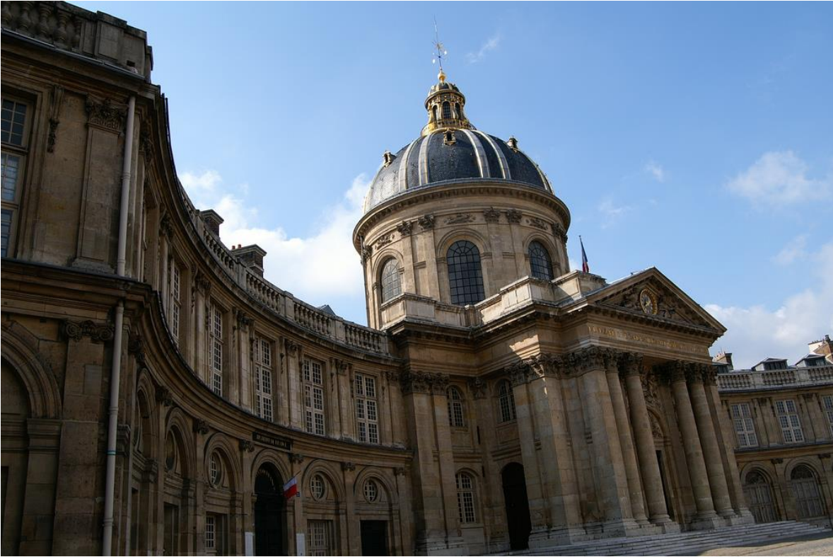
Figura 31. Colegio de las Cuatro Naciones, París, Francia. La edificación, que es del siglo XVII, muestra un estilo muy mesurado que se apega a los ideales clásicos y que sin embargo de la parte central salen las alas laterales que le brindan a la fachada una forma cóncava (Fuente: http://bit.ly/1NeAHT5 ).
