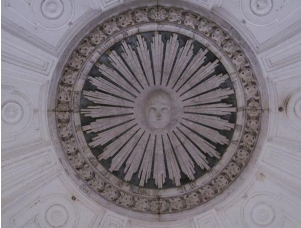
Figura 106. Rostro en la cúpula central de la Biblioteca del Palacio Nacional de Mafra, es una representación del sol y la iluminación (Fuente: http://bit.ly/1TDMkEW ).
