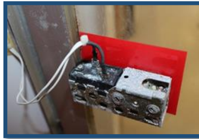
Figura 9. Control de Humedad.
