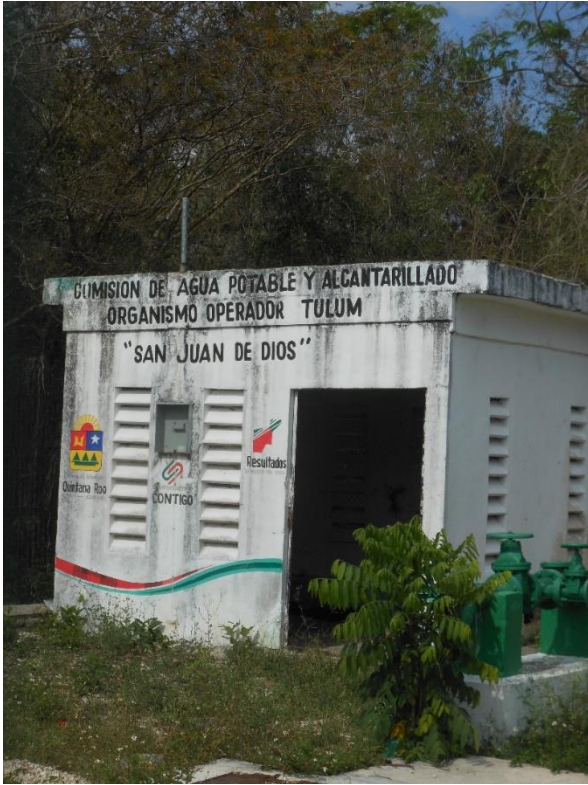
Planta de agua potable de S.J.D.
