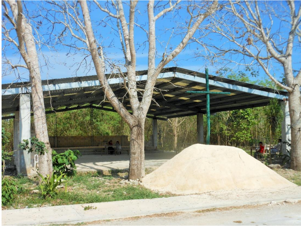
Iglesia católica en construcción
