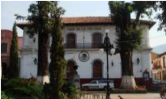
Fachada Principal Casa de la Cultura de Uruapan
