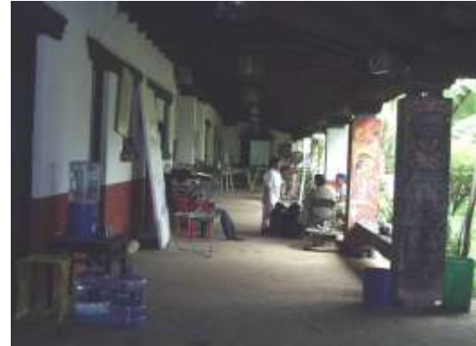
Arriba Pasillo principal vista suroeste – noreste. Abajo vestíbulo principal de acceso
