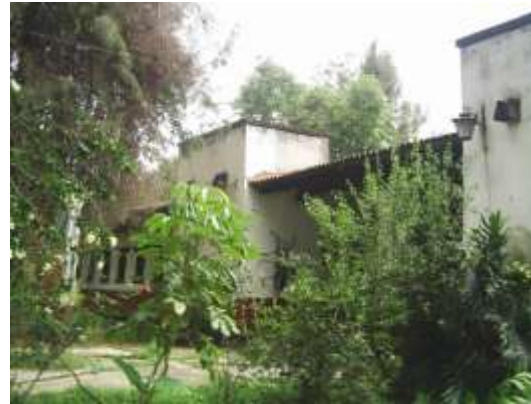
Vista principal de la construcción existente
