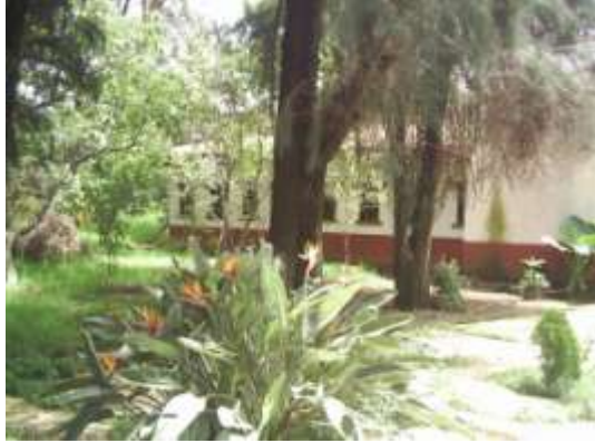
Vista sur-norte de la fachada principal
