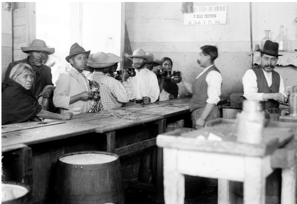
12. Entre las reglamentaciones de las pulquerías de la ciudad de México estuvo el cierre a las 13:00 los domingos y los días festivos. También en esta imagen se puede apreciar que el pulque era la bebida que predominaba en los espacios de recreación de las clases populares, y en el caso de esta pulquería las mujeres podían participar. Agustín Víctor Casasola, “Gente dentro de una pulquería”, México, D. F., [circa 1910], núm. inv. 6115, Fondo A, Archivo Casasola, Fototeca Nacional.
