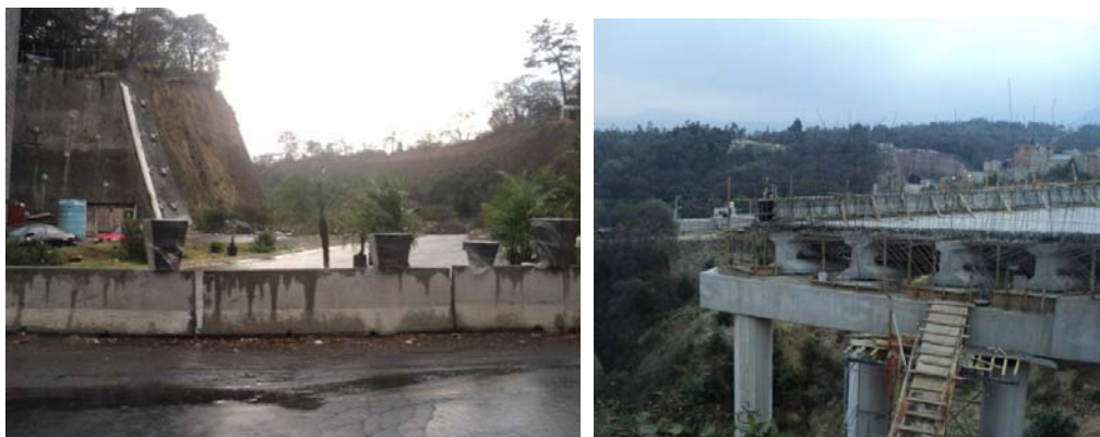
Construcción de la supervía poniente a la altura de "La Angostura", 2012
