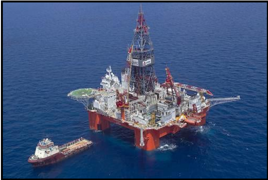
Figura 5.13. Vista aérea de la plataforma Bicentenario (La Jornada, 2011).
