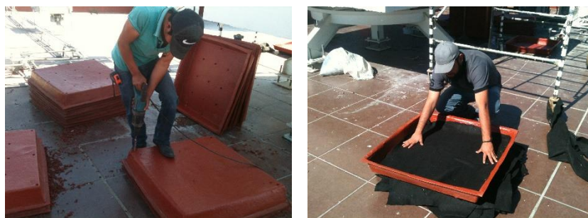
Fig.: 1 Preparación de charolas 2 Colocación de geotextil Fuente: Contreras López C. (2015)
