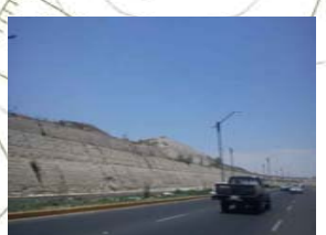
Presa de Jales Sur
