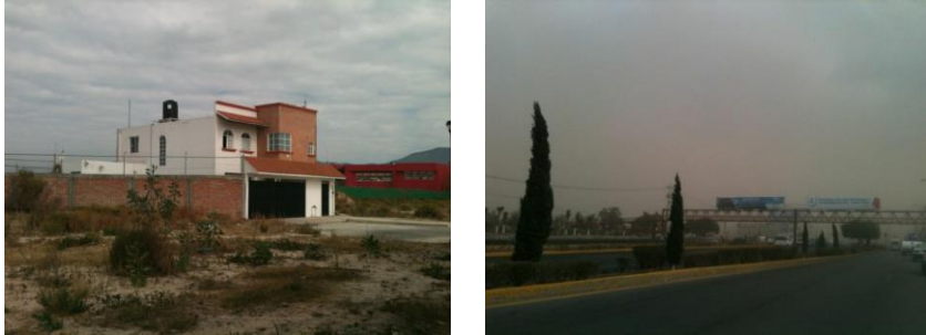
Fig.: 4 Viviendas con grietas y espacios con vegetación ruderal; 5 Tolvaneras provocadas en su mayoría por los jales. Fuente: Contreras López C. (2014)
