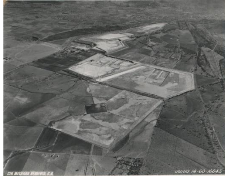
Fig.: 11. Depósito de jales mineros en 1960. Fuente: UAEH (1960)
