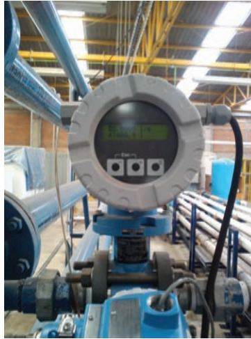
Figura 2.5: Sensor de flujo Promag 10D
