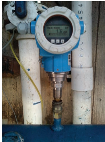
Figura 2.7: Sensor de presión Cerabar PMP71
