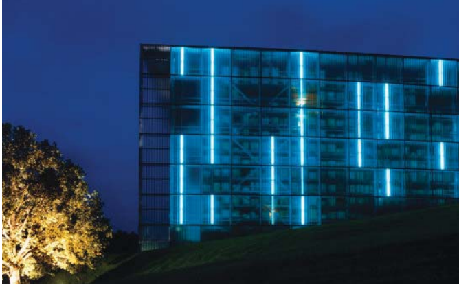
Hochregallager P3, Lüdenscheid, ERCO http://www.lde-net.com/lde_website/projects/industrial/erco_hochre_48/de/de_erco_hochre_projec_2.php
