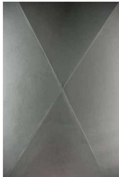
Bóveda por arista de la sala de remates en la antigua Bolsa Mexicana de Valores.
