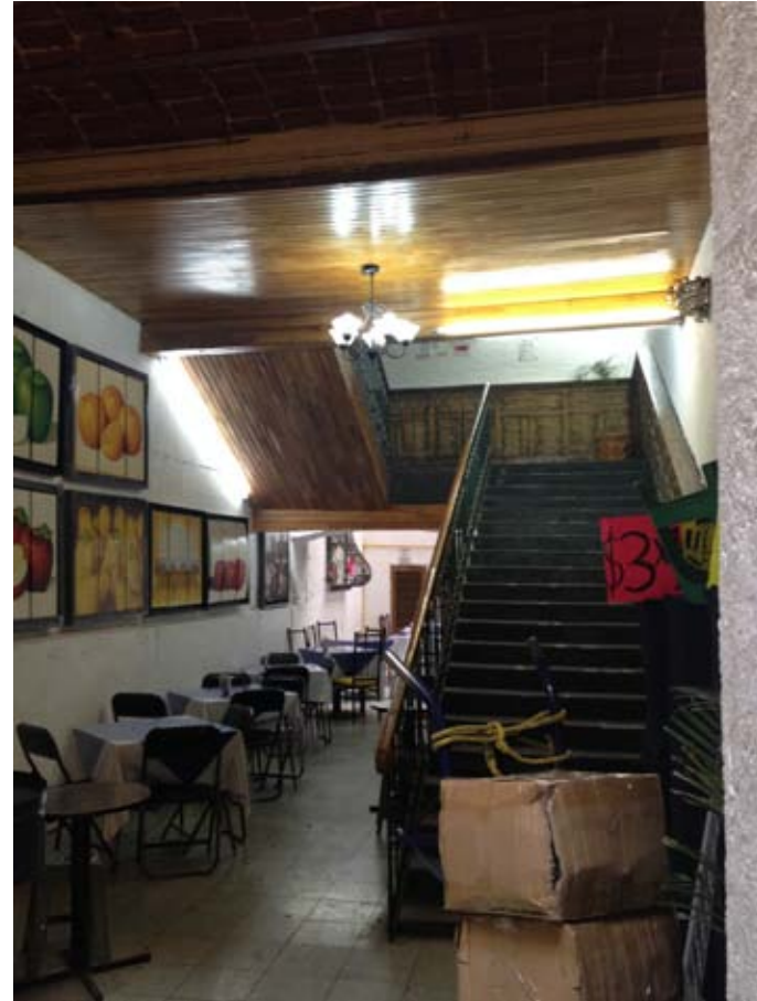
Vista actual de la escalera que aloja un restaurante debajo. Imagen tomada por el autor.
