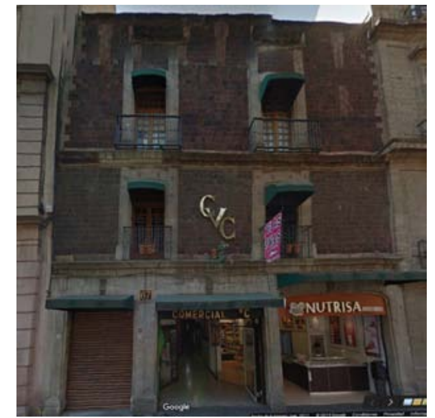
Fachada del edificio de Venustiano Carranza 67 en el año 2011. Imagen obtenida del servicio Street view de Google Maps.
