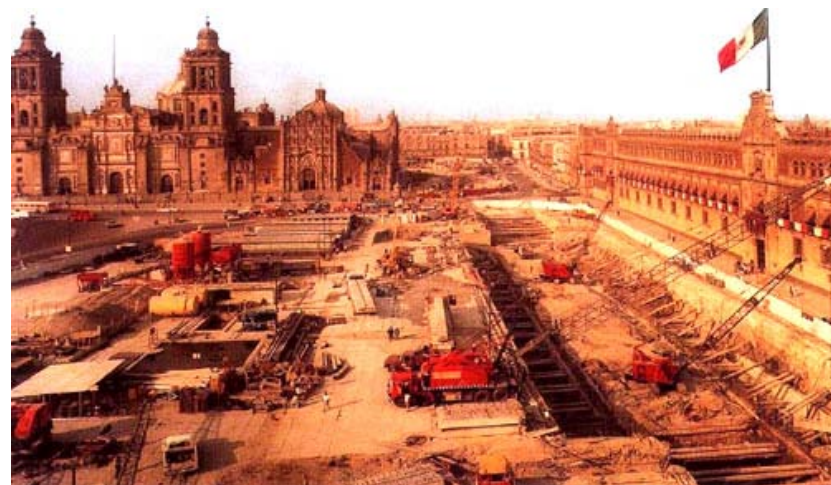
Obras del metro en el Zócalo de la Ciudad de México. Imagen obtenida de la red.
