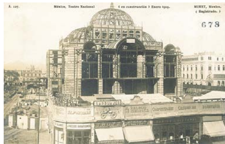
Construcción del Palacio de Bellas Artes, 1909. Imagen obtenida de la red.
