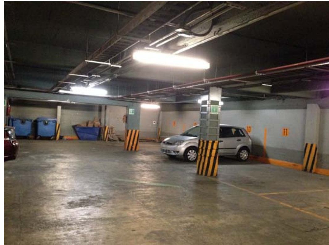
Vista actual del estacionamiento del edificio de la BMV. Imagen cortesía de Kenia Pichardo.
