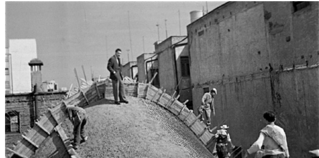
Félix Candela en una visita de obra durante la construcción de la bóveda. Imagen obtenida del documento Las bóvedas por arista: una aportación a la historia de la construcción. El caso de la Bolsa Mexicana de valores del Dr. Arq. Juan Ignacio del Cueto Ruiz-Funes.
