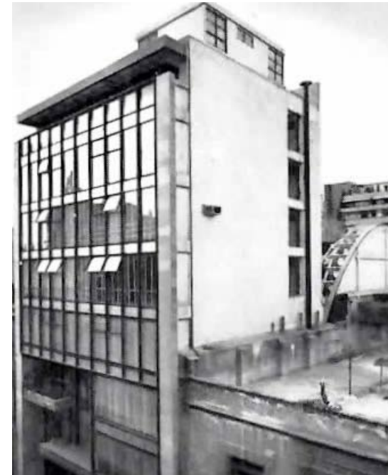
Fachada sur del edificio de la Bolsa Mexicana de Valores. Imagen obtenida de la red.
