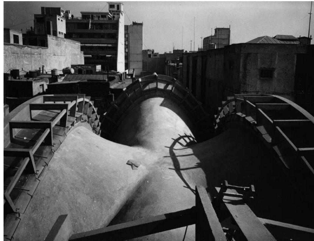
Vista exterior del cascarón de la sala de remates del edificio de la Bolsa Mexicana de Valores. Imagen obtenida del documento Las bóvedas por arista: una aportación a la historia de la construcción. El caso de la Bolsa Mexicana de valores del Dr. Arq. Juan Ignacio del Cueto Ruiz-Funes.
