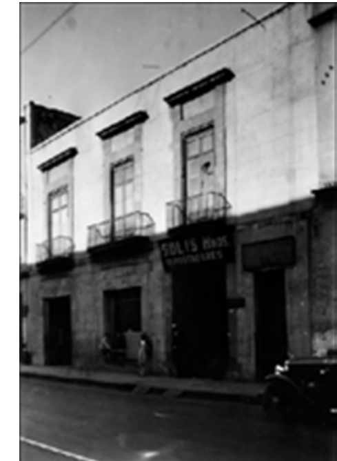
Edificio ubicado en República de Uruguay 1920-1930, antes de la construcción de la Bolsa de Valores. Imagen obtenida de DEH-CNMH-INAH.
