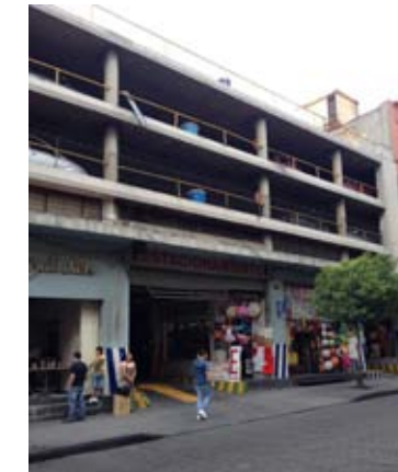
El mismo edificio de estacionamiento en la actualidad, con varios pisos menos y la fachada casi intacta. Imagen tomada por el autor.
