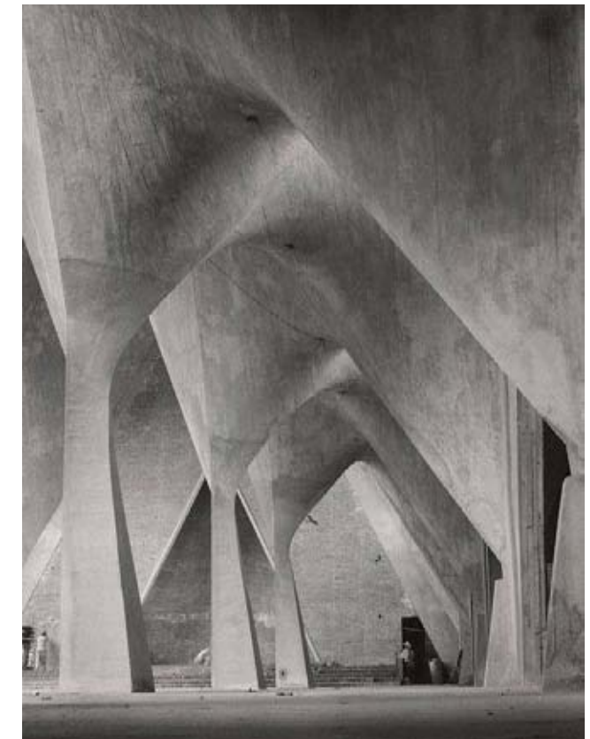
Interior de la Iglesia de la Medalla Milagrosa durante su construcción. Imagen obtenida de la red.
