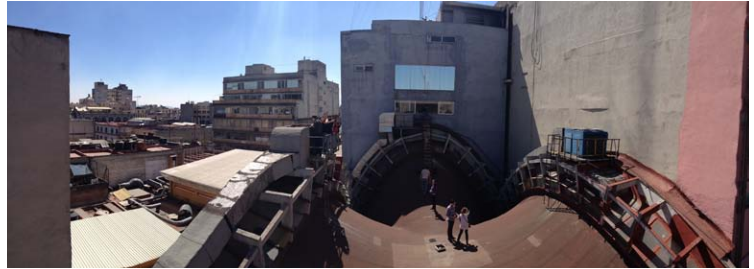
Vista actual del exterior de la bóveda por arista que cubre la sala de remates de la Bolsa Mexicana de Valores. Imagen tomada por el autor.
