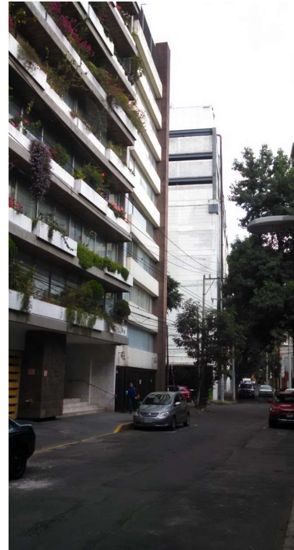
Vivienda en condominio en la calle de Cádiz
