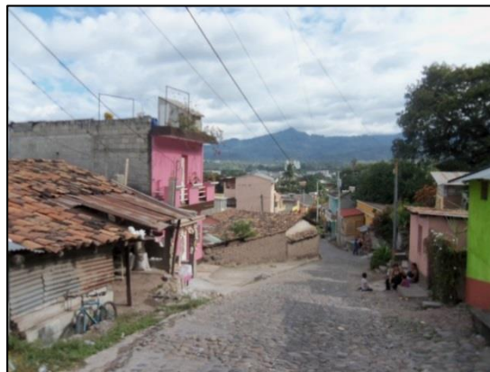
Figura 3.17. Esquipulas: estado de las construcciones
