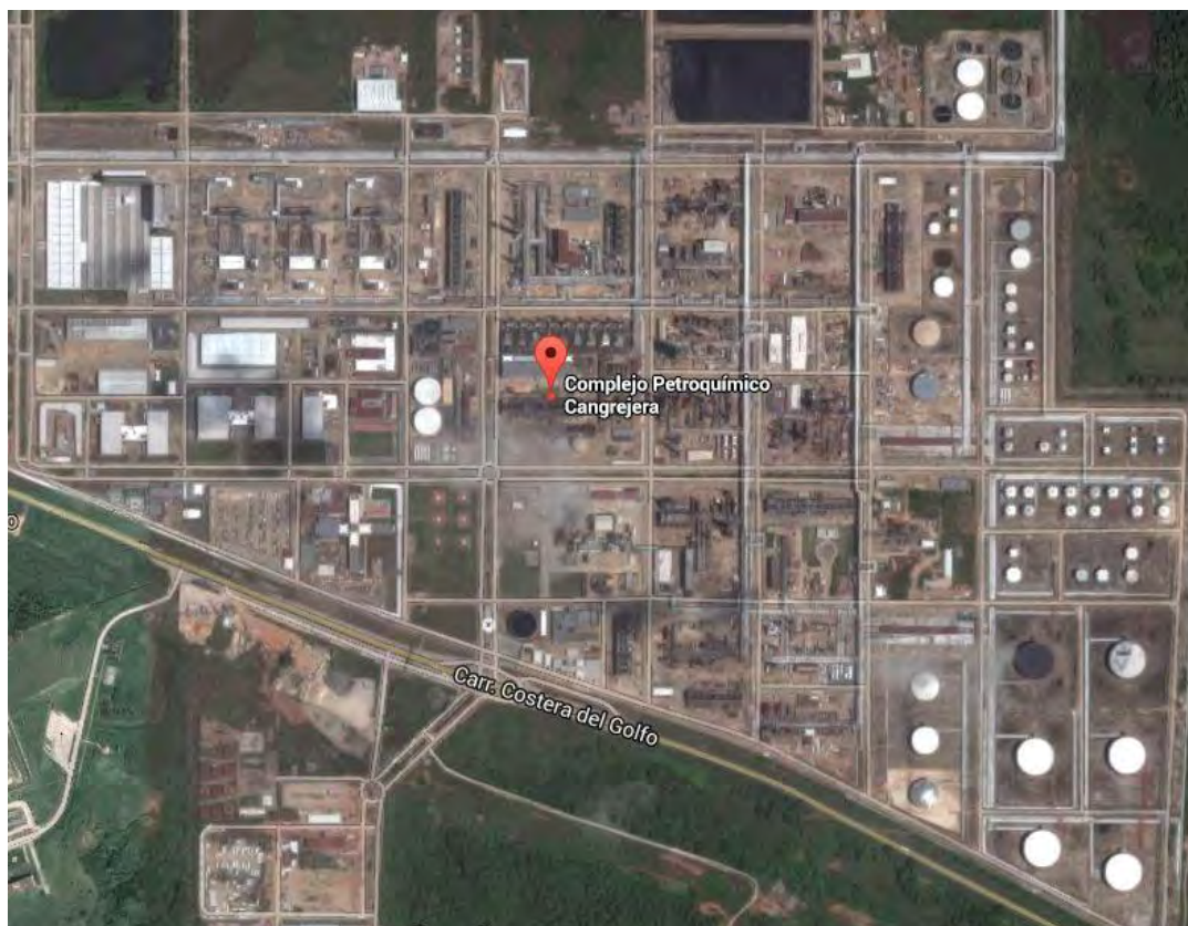
Figura 3-3 Vista Aérea del Complejo Petroquímico de La Cangrejera.
