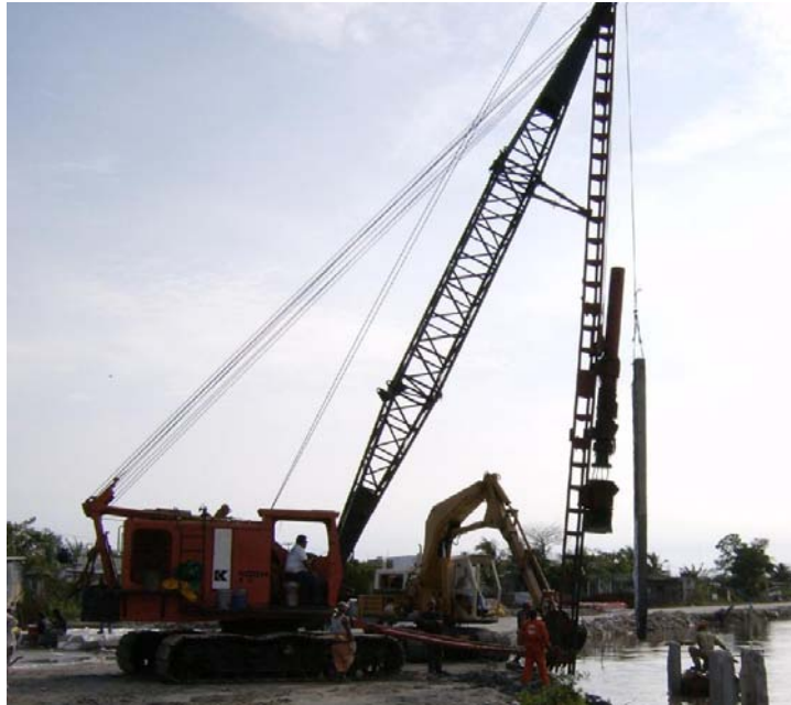
Figura 6.13. Hincado de tabletas.
