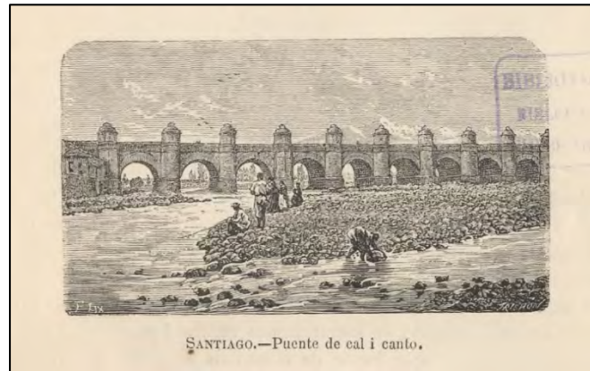
Figura 2.2 Santiago: puente Cal y Canto al norte de la ciudad
