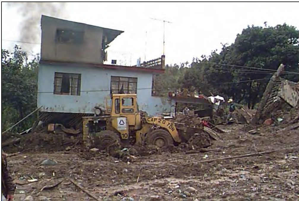
Fig. 51. Afectaciones del fenómeno en la colonia La Aurora (foto: SEDENA).
