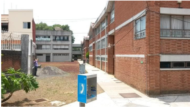
Área entre edificios 1 al 4 y biblioteca.
