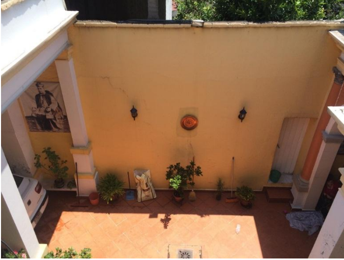
Vista de patio central desde azotea
