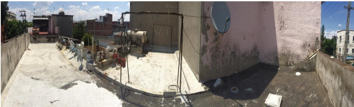
Vista panorámica de la azotea
