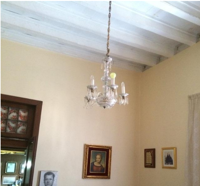
Viguería en el techo de una de las recámaras
