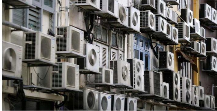
Figura 3: Equipos de ventana ubicados en la fachada de un edificio por una mala estrategia de diseño de climatización. Sistemas unitarios de expansión directa
