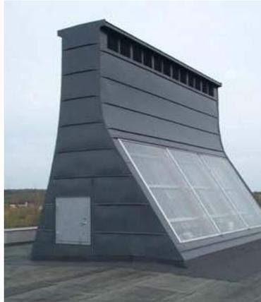
Imagen 1.10: Modelo de chimenea solar en azotea de una vivienda sin tiro en fachada.
