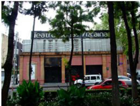
1. Fachada teatro de las Vizcaínas.
