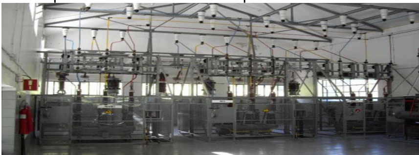
Figura 2-8 Subestación tipo interior.
