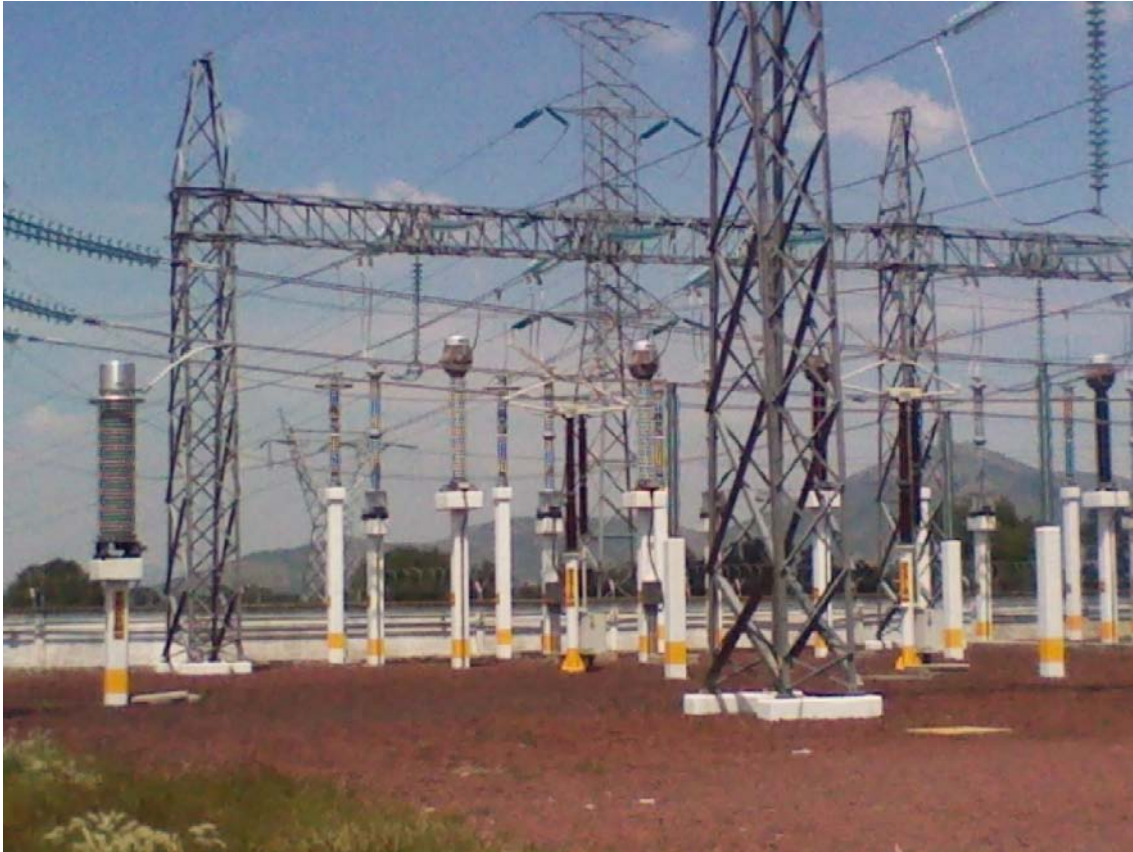
Figura 2-5 Subestación primaria.
