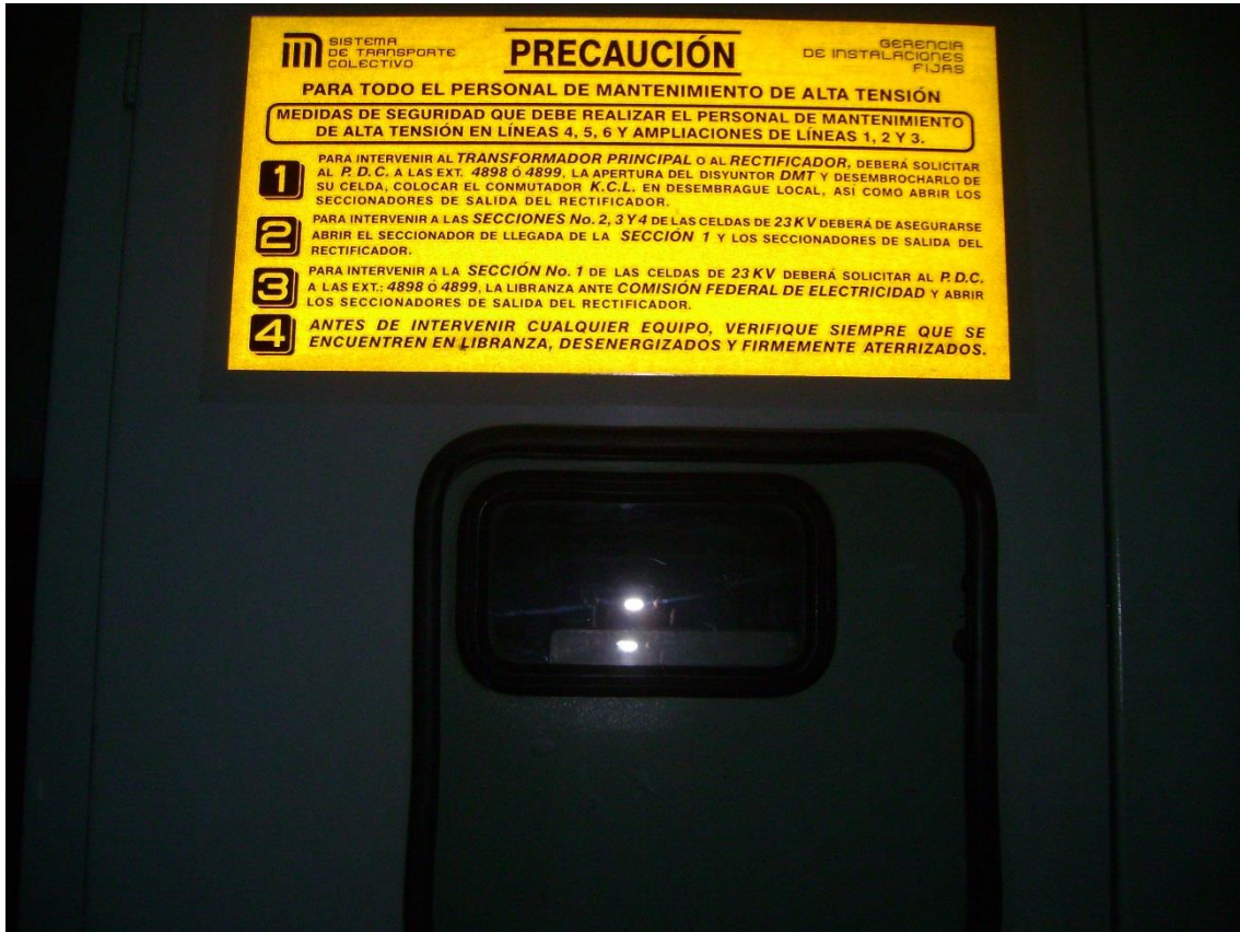
Figura 4-5 Leyendas instaladas en paredes de la SR (subestación de rectificación).
