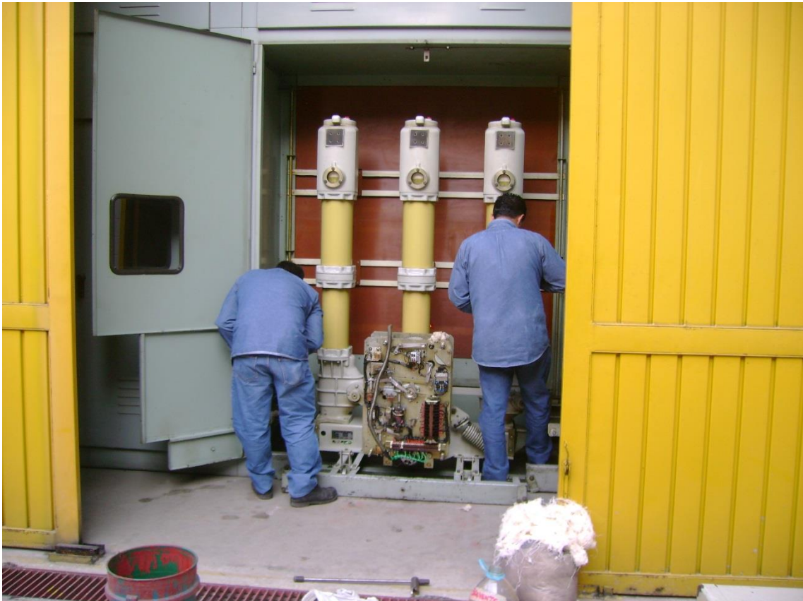
Figura 4-14 Disyuntor de mediana tensión de pequeño volumen de aceite.
