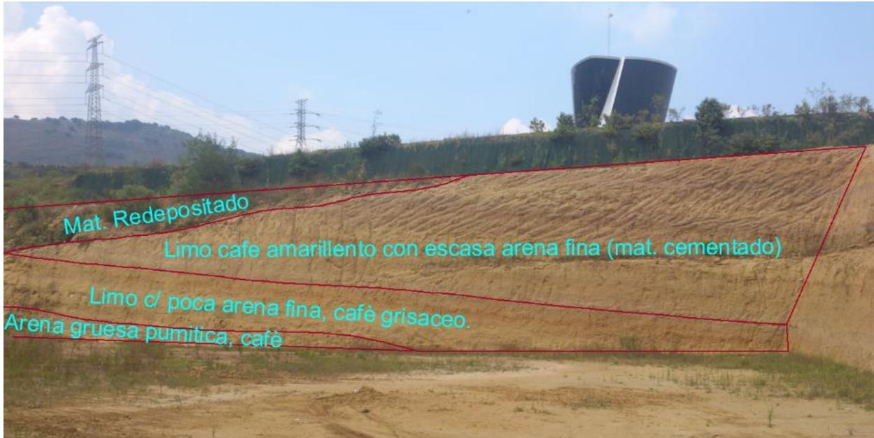
FIGURA 22. PERFIL ESTRATIGRÁFICO TALUD – 2
