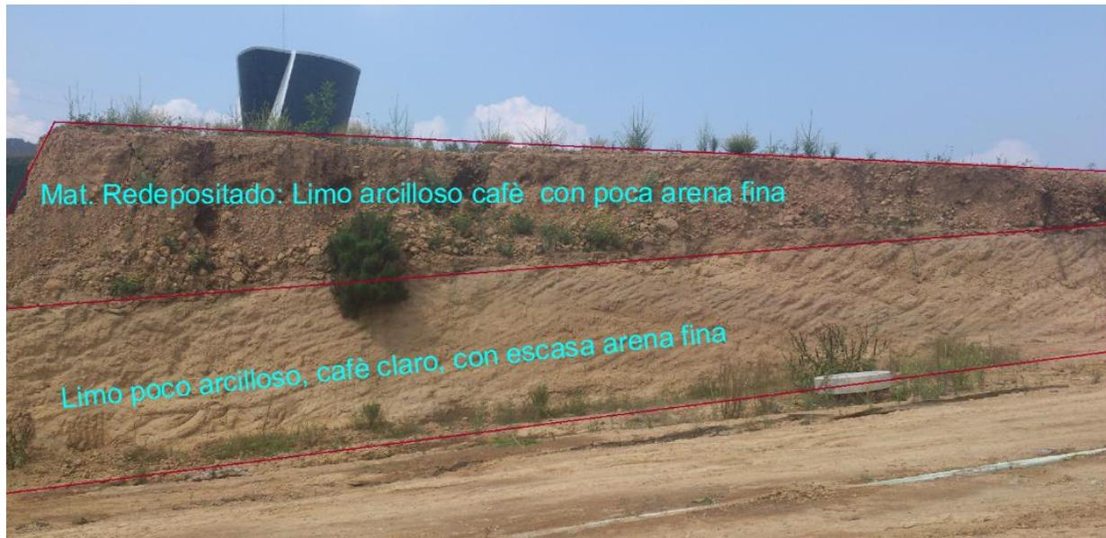
FIGURA 25. PERFIL ESTRATIGRÁFICO TALUD – 5
