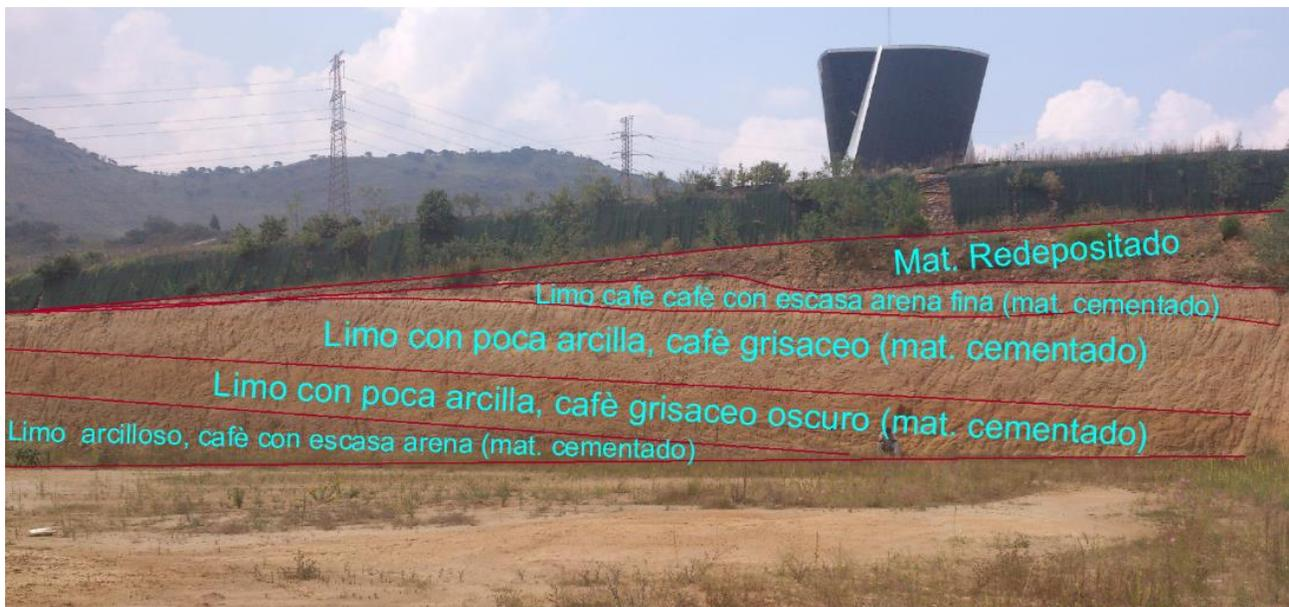
FIGURA 23. PERFIL ESTRATIGRÁFICO TALUD – 3
