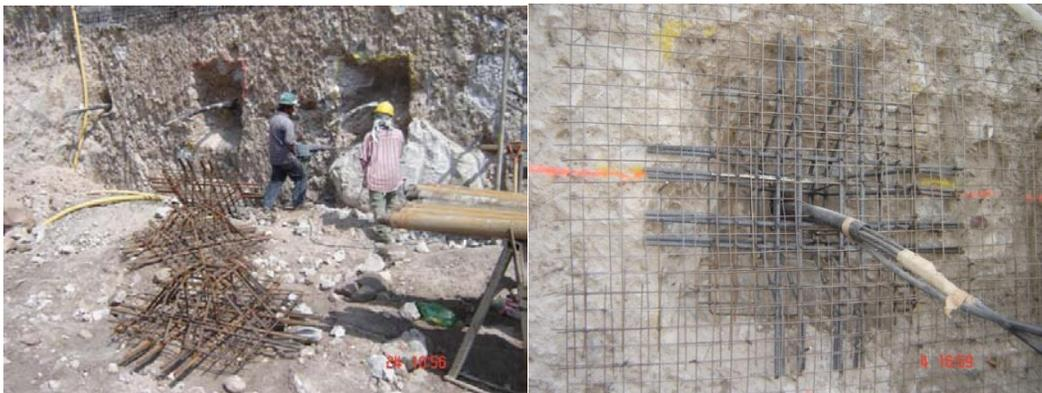
Se aplica una capa de concreto lanzado de 6 cm de espesor y en el punto de aplicación se colocará un sobre-espesor de 20 cm más y exterior como se muestra en la figura 63.
