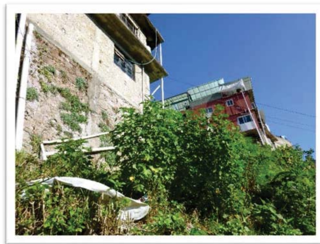
Figura 4.27. Tuberías conectadas a una canaleta en colonia Juárez, Teziutlán, Pue. Octubre 2015. Fotografía tomada por Felipe Juárez.
