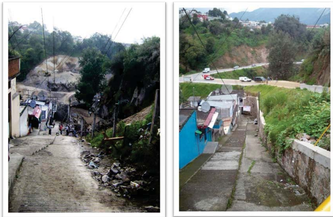
Figura 3.31. Construcción de circuito Bicentenario. Junio 2011 (izquierda), septiembre 2012 (derecha). Fotografías tomadas por Felipe Juárez.
