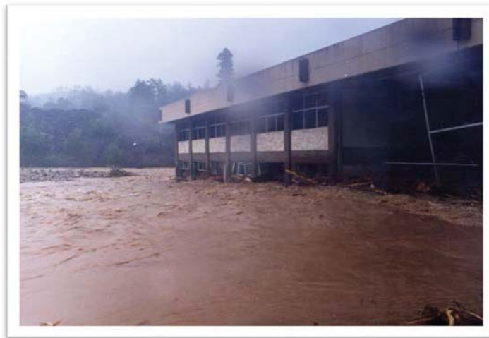
Figura. 3.3. Afectaciones en el Instituto Tecnológico Superior (ITS), Teziutlán, Pue Octubre 1999. Fotografía tomada por Policía Municipal de Teziutlán.
