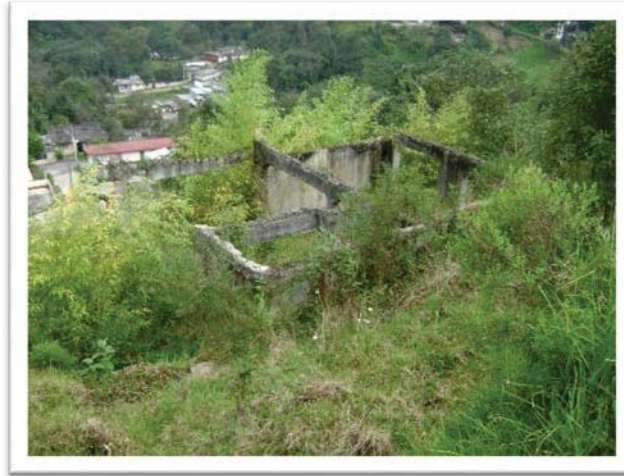
Figura 4.22. Vivienda abandonada en 1999 en la colonia La Aurora, Teziutlán, Puebla. Octubre 2013. Fotografía tomada por Felipe Juárez.
