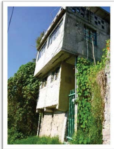
Figura. 4.23. Reutilización de muro de contención en la colonia Juárez, Teziutlán, Pue. Octubre 2015. Fotografía tomada por Felipe Juárez.
