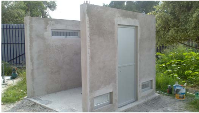
Figura 3.5. Muros sur con ventana en la parte superior, muro norte con puerta y un par de ventanas inferiores.
