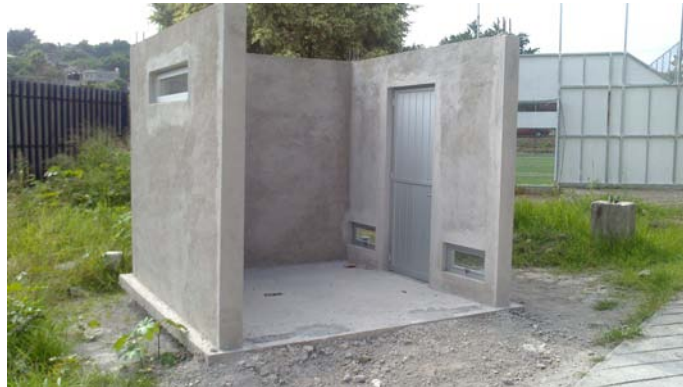
Figura 3.4. Sistema constructivo en muros sur, norte y oeste.
