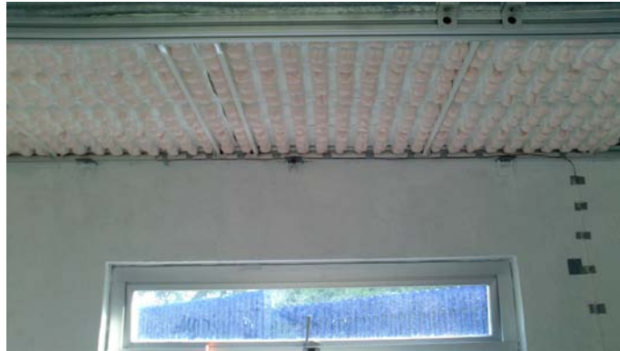
Figura 3.7. Techo con BioPCM M91-Q25.
