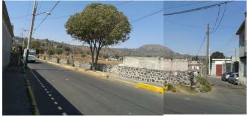
Figura. Vista general del terreno desde la calle Cholula y Av. Puebla.
