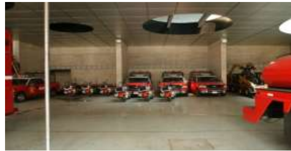
Imagen. Patio de vehículos, Estación de bomberos Ave Fenix. México, D.F. Fuente: Archdaily.
