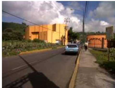
Fotografía. Vista de acceso a la Av. Puebla
