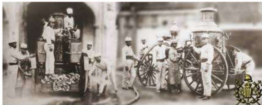
Imagen de bombas utilizadas en la ciudad de México. Fuente http://www.bomberos.df.gob.mx/ .
