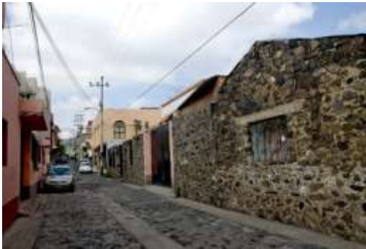
Figura 7. Tipología en las construcciones de la delegación.
