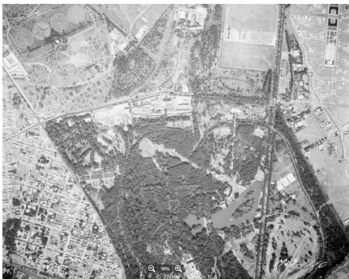
Imagen 29. (1946) Fotografía aérea del bosque y sus alrededores, en la que se observan los cuatro tanques de almacenamiento de agua en la parte superior izquierda, así como el terreno sobre el cual se ubica actualmente el Auditorio Nacional del lado superior derecho. En la parte inferior izquierda se encuentra la colonia San Miguel Chapultepec. Fuente: Archivo histórico de ICA
