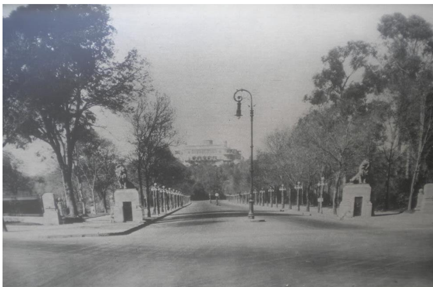
Imagen 26. Se puede observar el acceso del Bosque ya con los leones que caracterizan el acceso principal, 1926. Fuente: Galería fotográfica: el México de ayer.
