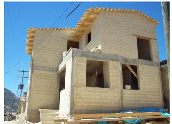
Ilustración 0-5, construcción de proceso constructivo mixto.
