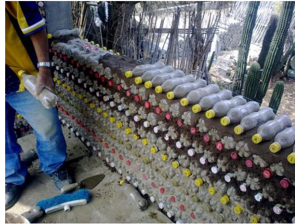
Construcción de baño seco utilizando botellas de pet rellenas de arena.
