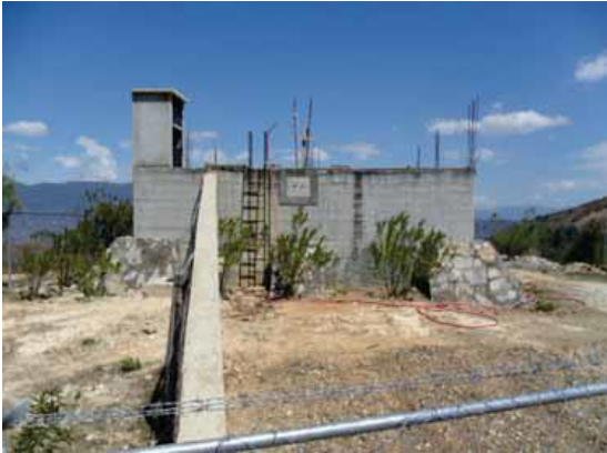
Ilustración 0-39, tanque de agua.
