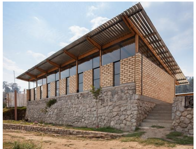
Aula Rural Xilitla (2011), de Taller Max Cetto de la Facultad de Arquitectura de la UNAM
