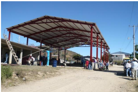
Ilustración 0-19, techumbre patio de usos múltiples de telesecundaria.
