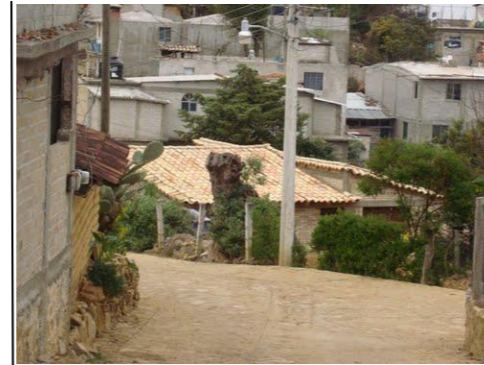
Calles principales pavimentadas
