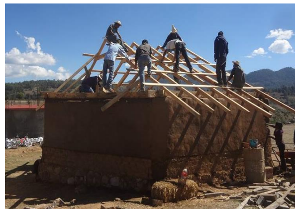
Colocación de techumbre
