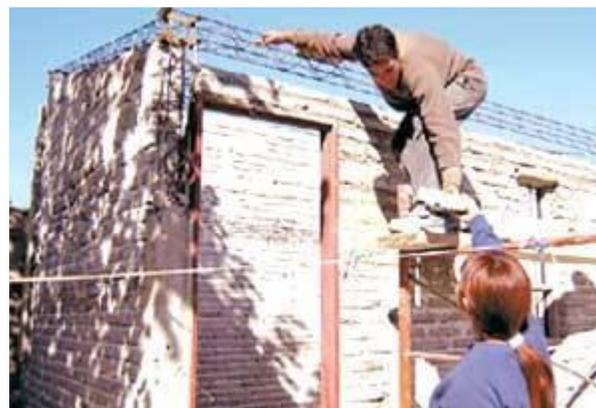
115 Uno de los prototipos construidos con ladrillos de papel reciclado.
