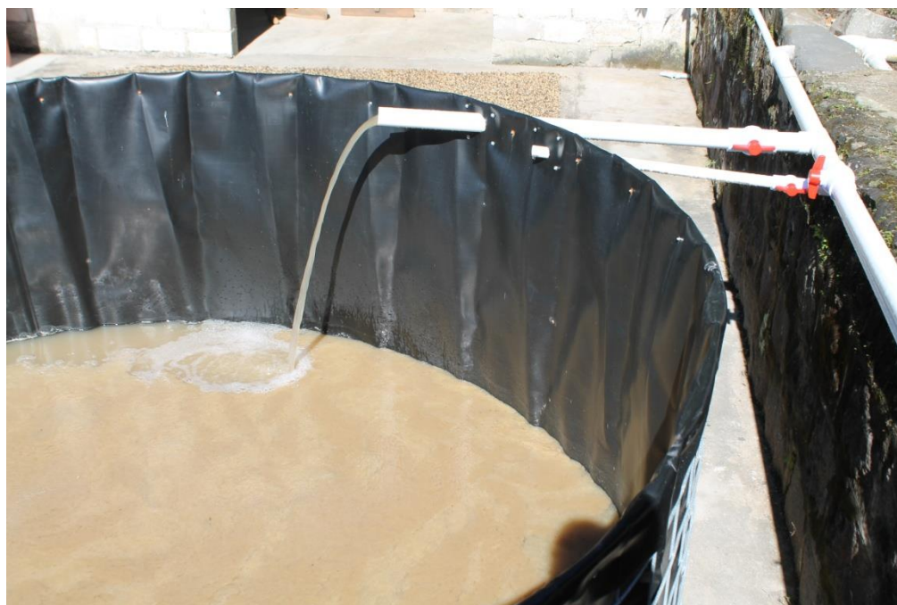
Figura 6.11 Entrada de agua residual en descarga libre
