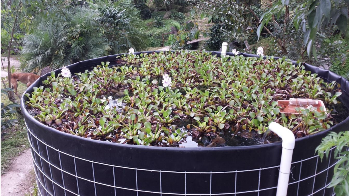
Figura 6.15 Tanque #3 del tratamiento terciario cubierto con lirio acuático (Eichhornia Crassipes)
