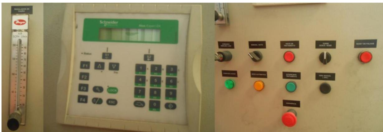
Figura 25. Controles de la unidad de desgasificación, Izquierda; flujómetro, centro; panel de control automatizado, derecha; perillas de control manual.
