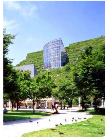
4.13 Terraza escalonada del Fukuoka Prefectural Internacional Hall, Fukuoka Japón
