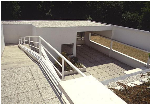
Imagen 4.8 Vista del interior del terrado-jardín de la Villa Savoie
