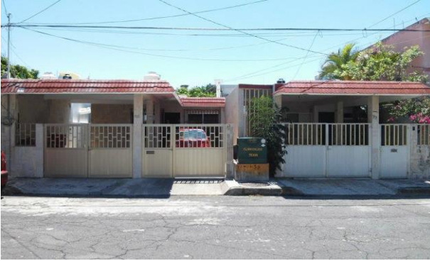
Foto 5.4 fachada de la vivienda
