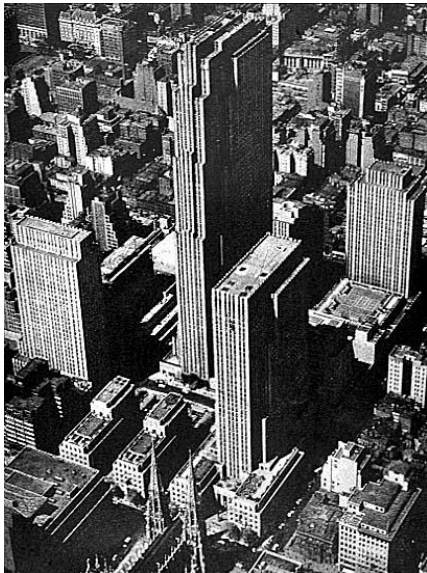
Imagen 3.15 Vista de las azoteas del Rockefeller Center y edificios de su alrededor.
