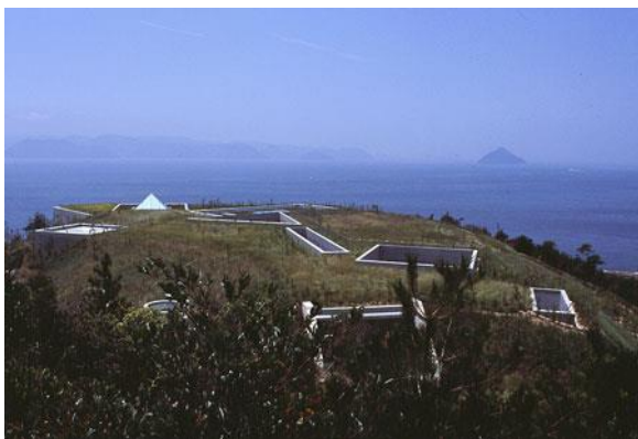
Imagen 4.30 Vista de la quinta fachada del edificio. Vista general de la isla.
