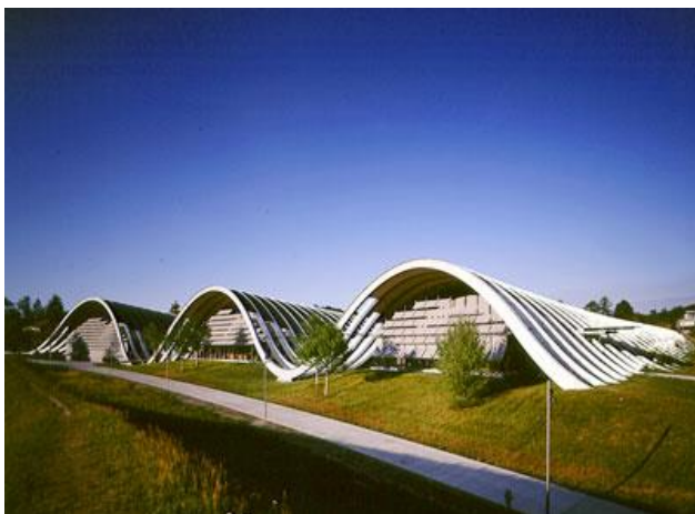
Imagen 4.28 Vista en perspectiva de la fachada del edificio
