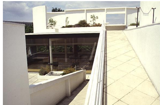
Imagen 4.9 Vista del interior del terrado-jardín de la Villa Savoie
