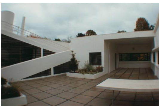
Imagen 2.12 Vista de la terraza de la Villa Savoie de Le Corbusier .
