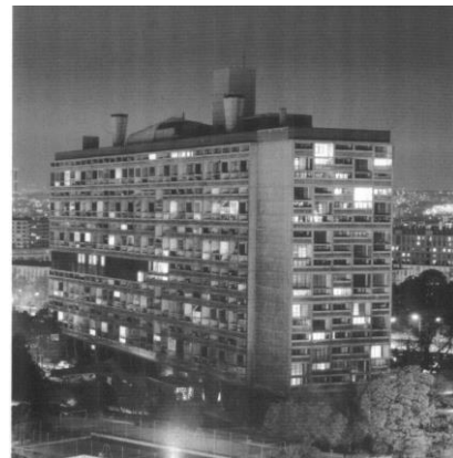
Imagen 4.22 Vista de noche de la Unidad Habitacional de Marsella. Semejanza entre el edificio y un barco.
