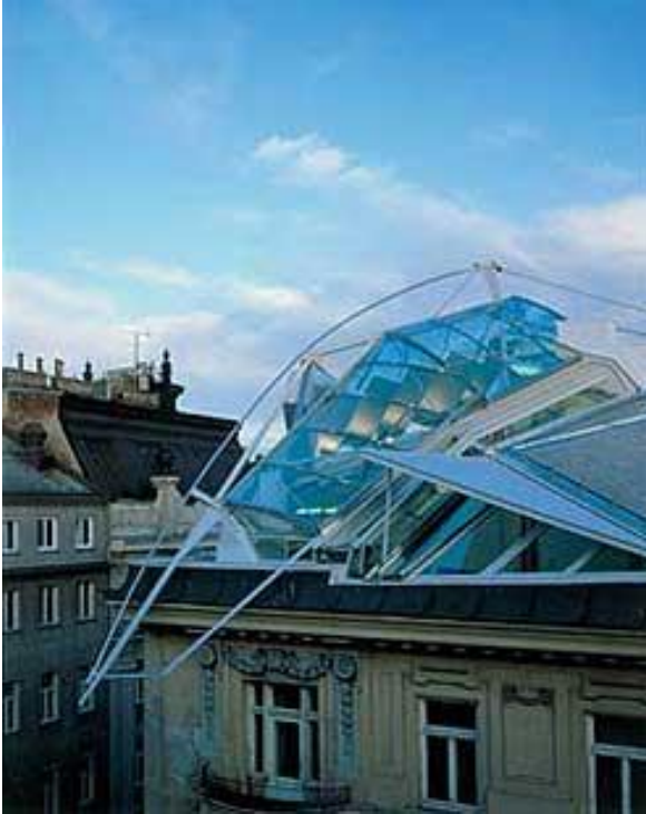
Imagen 2.15 Coophimmelblau, Rooftop Remodelling Falkestrasse, Vienna, Austria
