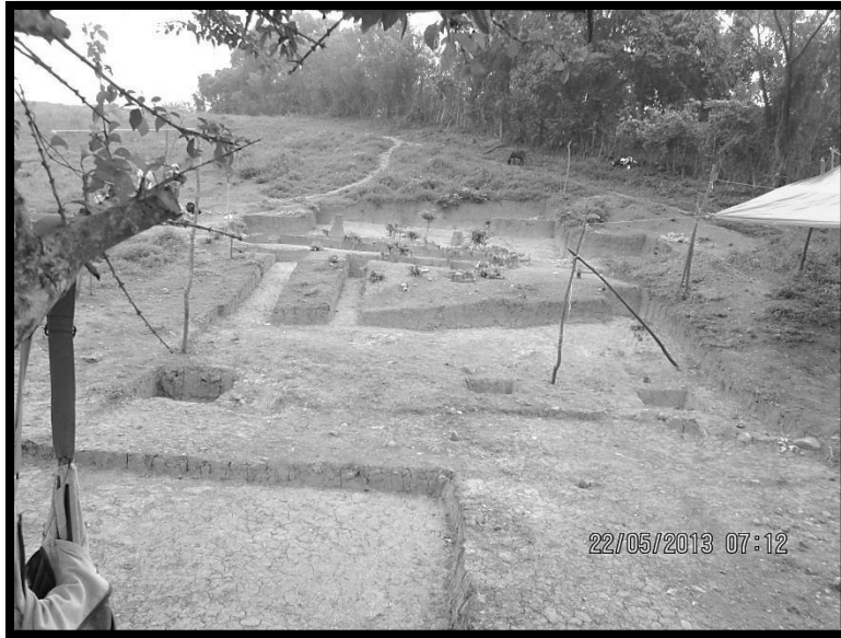
Foto 23. Fin de excavación de la Unidad 1. De sur a norte. Vista del acceso terraceado, en primer plano segundo escalonamiento.
