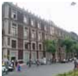
Nacional de Piedad. Fundado en 1775 por Pedro Romero. Predomina el macizo sobre el vano. 4 niveles. Fachada de Tezontle.
