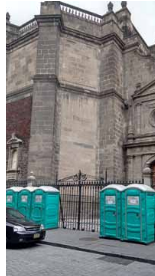
Servicios sanitarios detrás de la Catedral Metropolitana.
