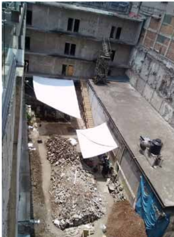
Interior del edificio, se aprecia trabajo de excavación.
