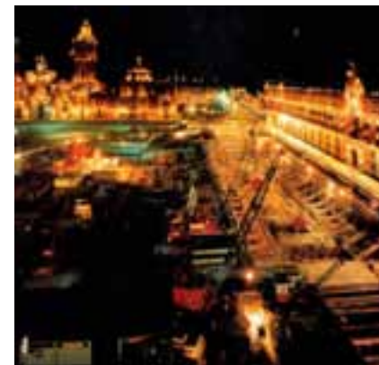
Imagen 2. Construcción de la estación del metro Zócalo en frente de Palacio Nacional.
