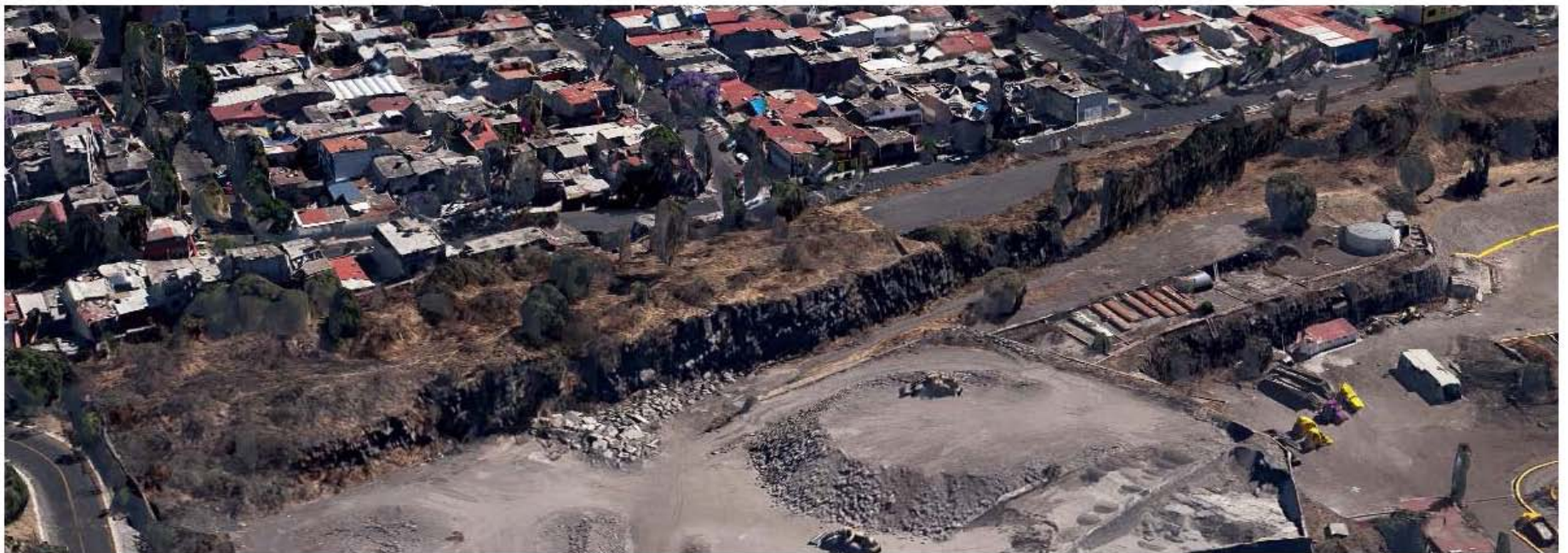
Imagen Aérea del Terreno.
