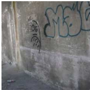
Pintura en aerosol en repellados.
