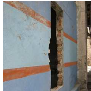
Retiro de ventanas, puertas y molduras de madera.
