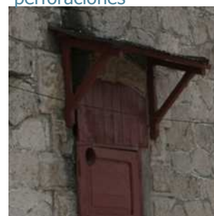
Láminas en fachadas
