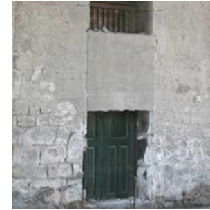
Vanos cegados con muros de block.
