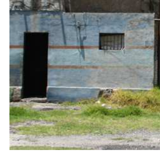
Erosión de pintura en muros por exposición al sol.
