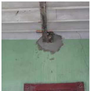
Perforación en muros para soporte de cubiertas.
