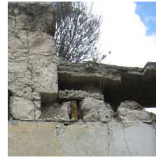
Crecimiento de flora parásita en azotea por acumulación de agua.
