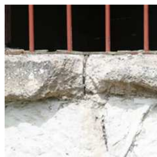
Pulverización de repisones de cantera.
