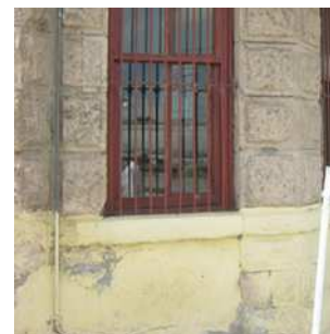
Pintura vinílica en muros
