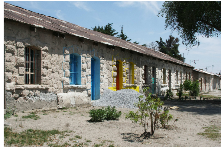
Antiguas casas de sección habitadas hoy por ferrocarrileros jubilados. Se respetará su vocación de vivienda simplemente se dará mantenimiento para dar unidad al conjunto.
