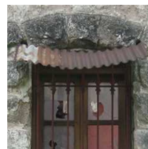
Colocación de láminas en fachadas.
