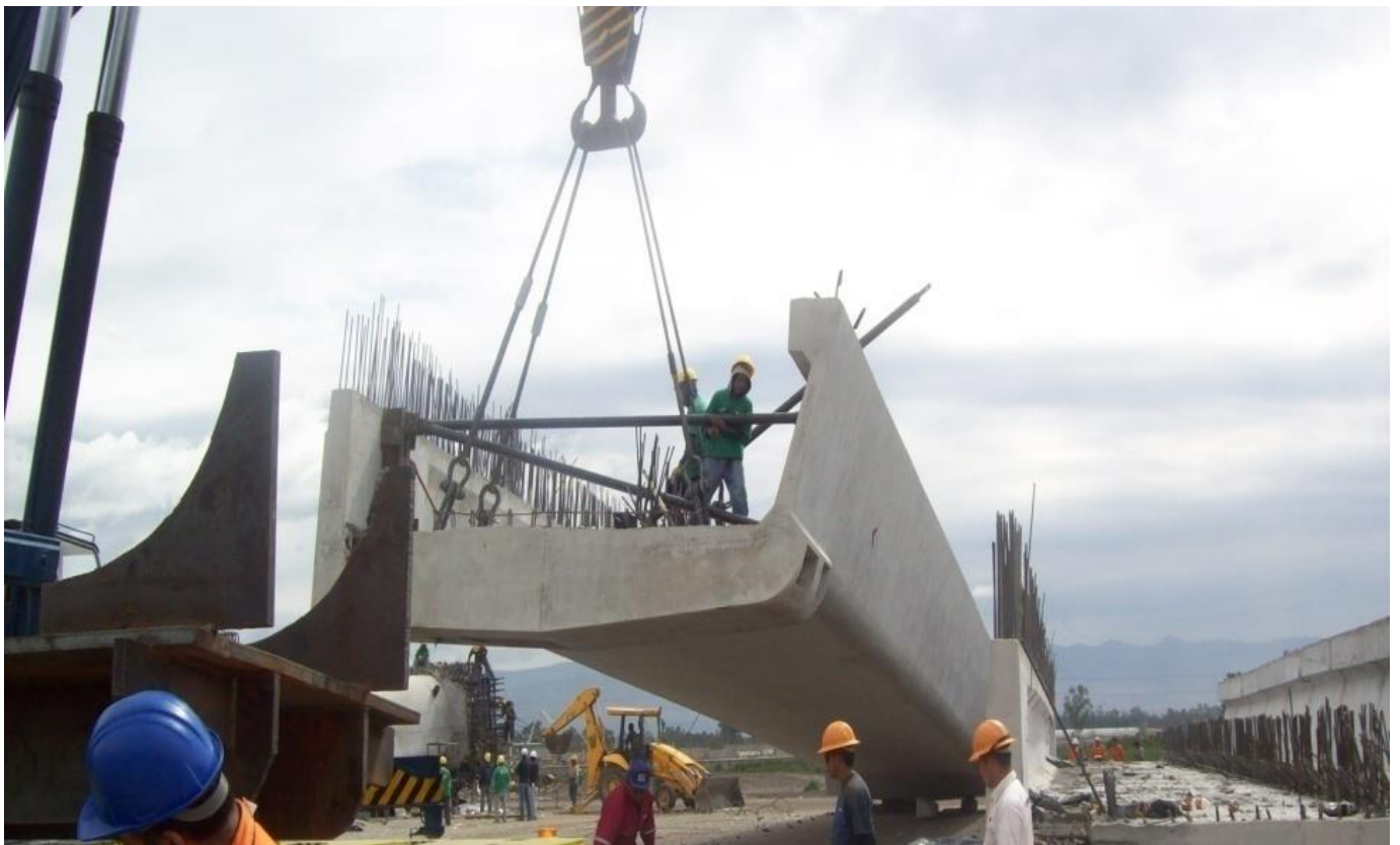
Figura IV.3.16.- Transporte-estiba. (Foto tomada por el autor)
