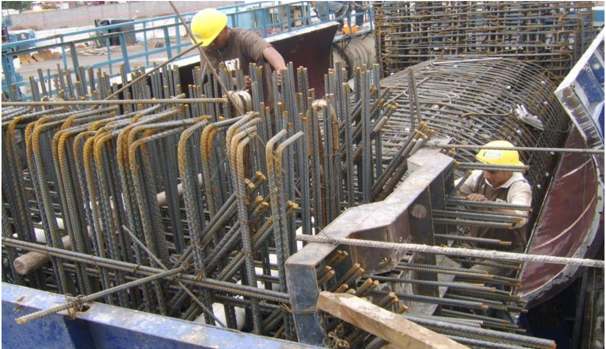
Figura IV.2.11.- Elemento dentro del molde listo para el colado (Foto tomada por el autor)
