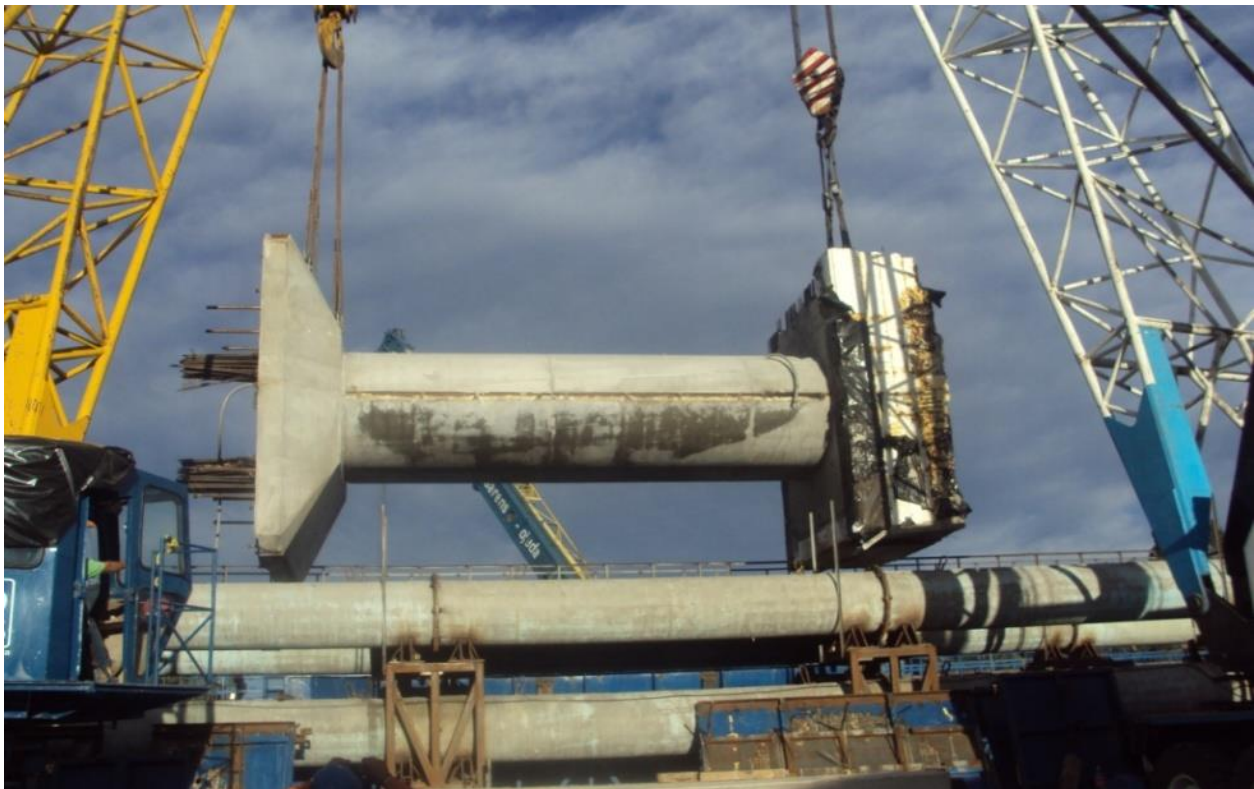
Figura IV.2.15.- Columna fuera del molde (Foto tomada por el autor)
