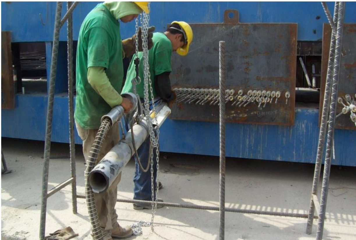
Figura IV.3.12.- Tensado del torón. (Foto tomada por el autor)
