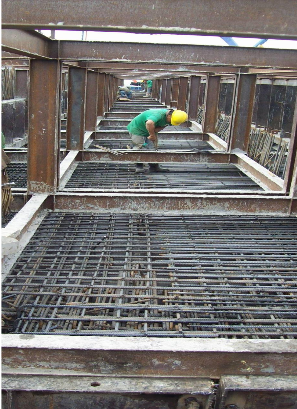
Figura IV.3.10.- Cimbra flotante dentro del molde. (Foto tomada por el autor)
