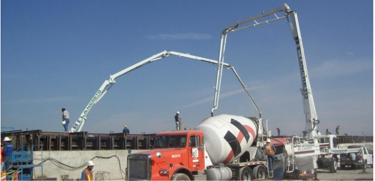
Figura IV.3.13- Colado de la trabe. (Foto tomada por el autor)
