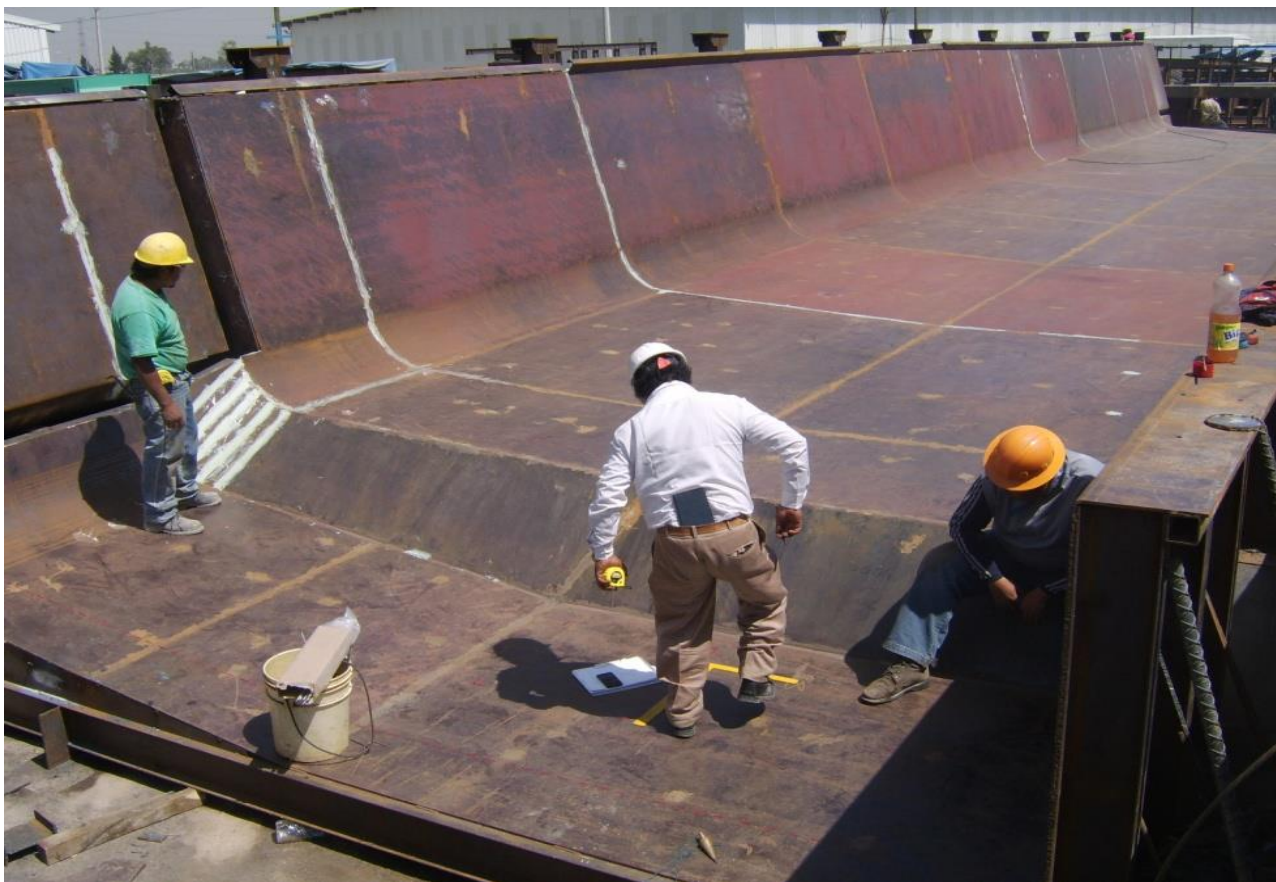
Figura IV.3.1.- Topografía del molde. (Foto tomada por el autor)
