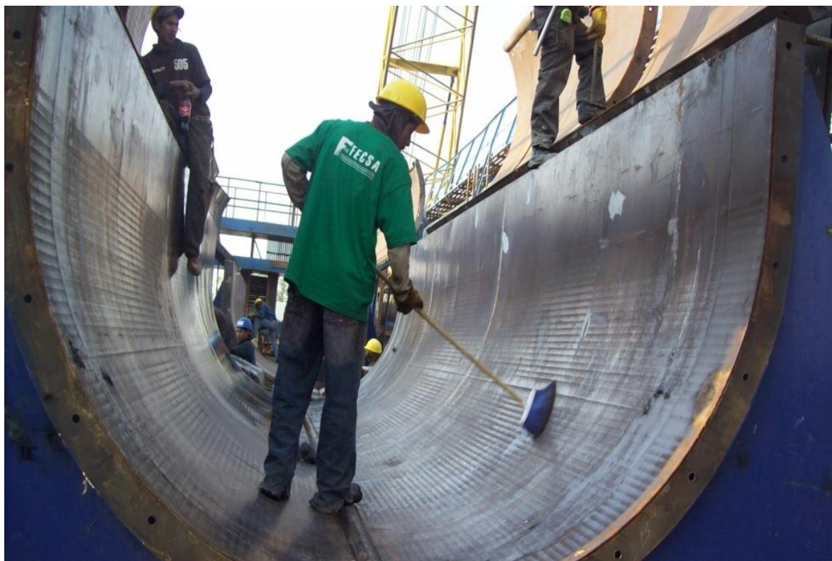
Figura IV.2.2.- Limpieza del molde (Foto tomada por el autor)
