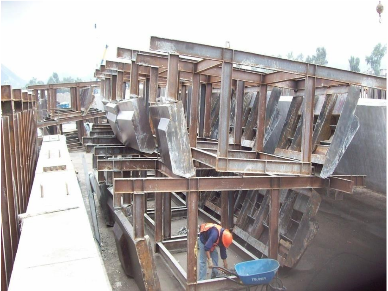
Figura IV.3.9.- Cimbra flotante. (Foto tomada por el autor)
