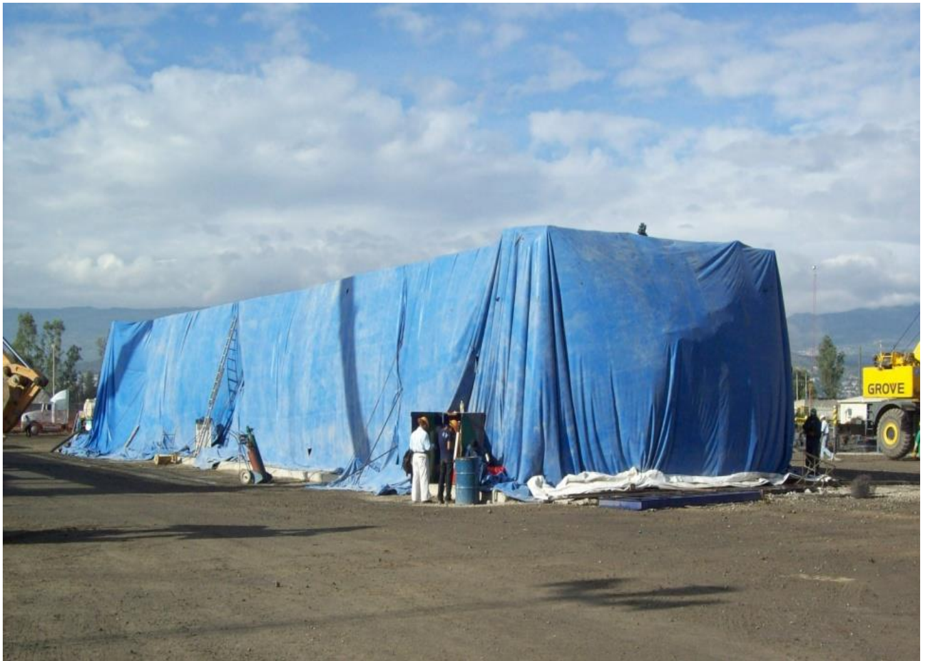
Figura IV.2.13.- Curado a vapor. (Foto tomada por el autor)
