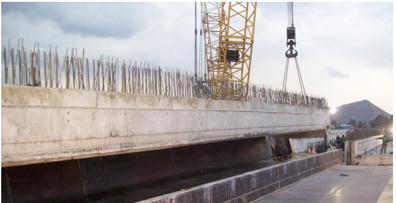
Figura IV.3.15.- Trabe fuera del molde. (Foto tomada por el autor)
