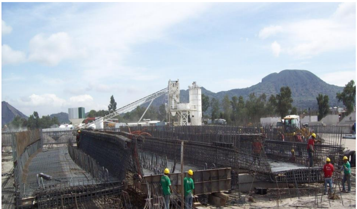
Figura IV.3.5.- Armado de acero. (Foto tomada por el autor)
