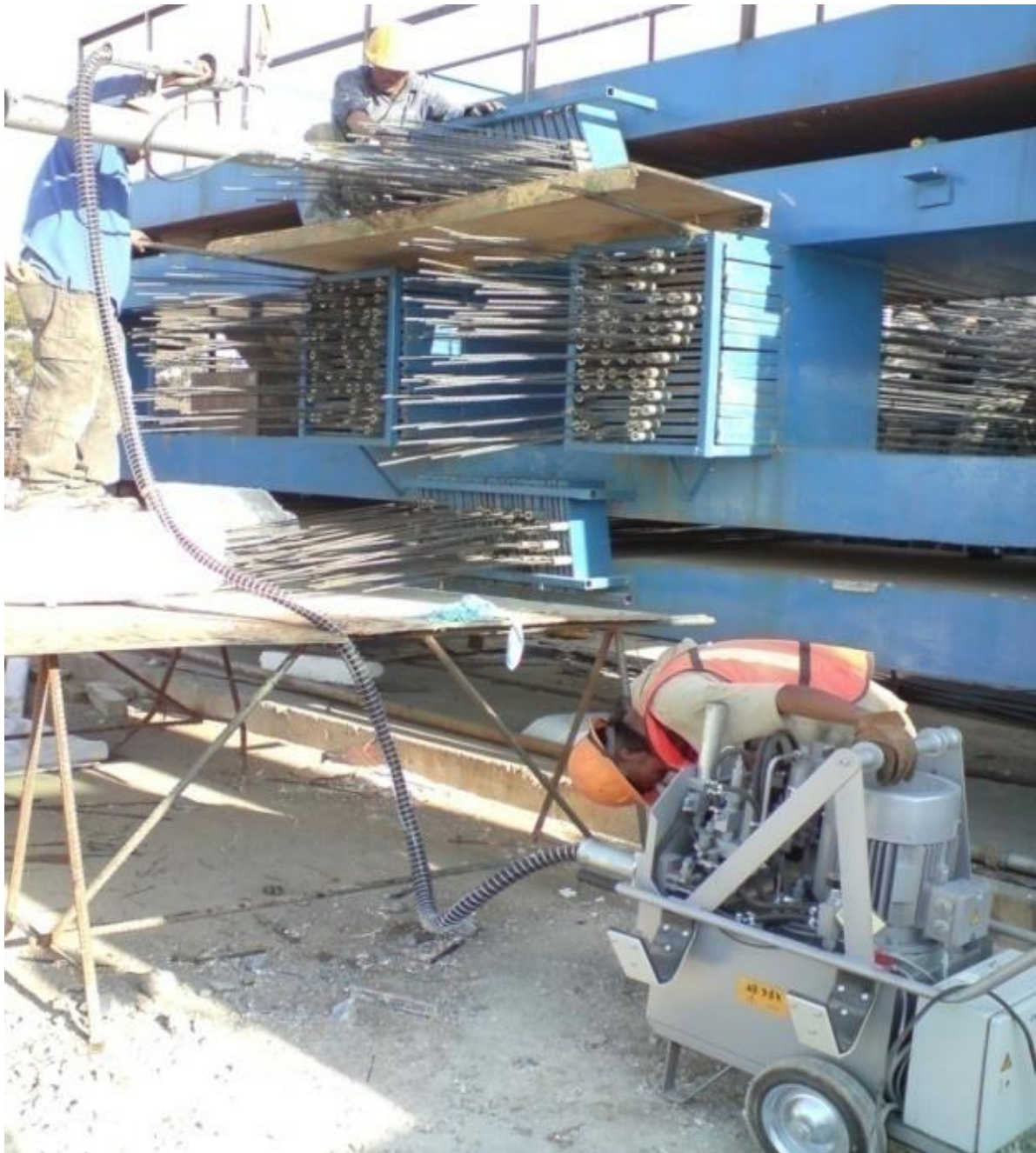
Figura IV.2.10.- Tensado del torón (Foto tomada por el autor)
