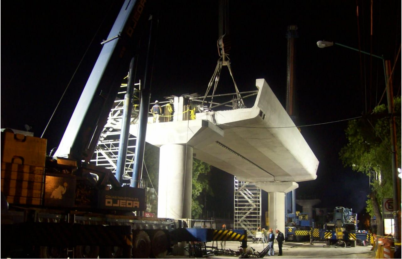
Figura IV.3.19 .- Montaje de la trabe (foto tomada por el autor)
