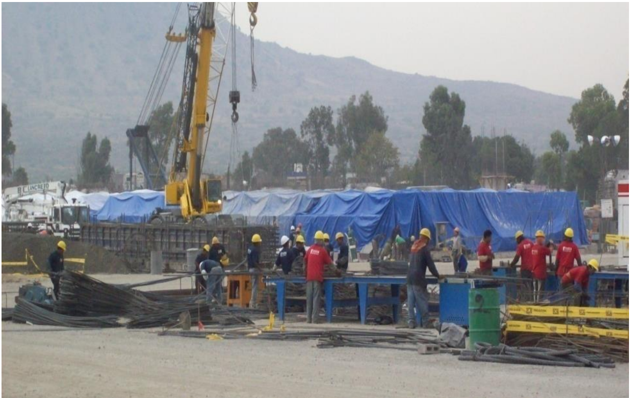
Figura IV.3.14.- Curado a vapor. (Foto tomada por el autor)
