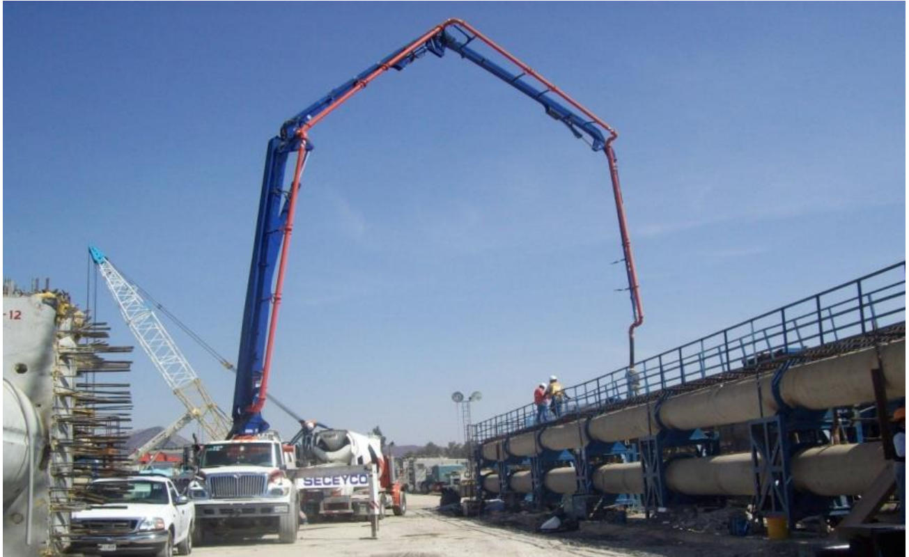
Figura IV.2.12.- Bomba de concreto (Foto tomada por el autor)
