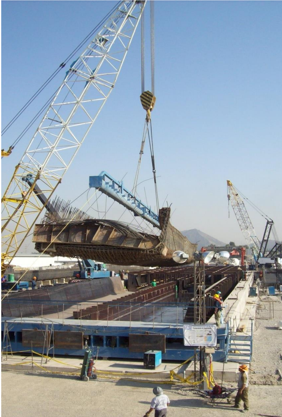
Figura IV.3.8- Introducción del armado al molde. (Foto tomada por el autor)
