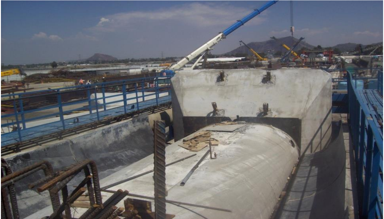
Figura IV.2.14. - Columna después del colado (desmolde) (Foto tomada por el autor)
