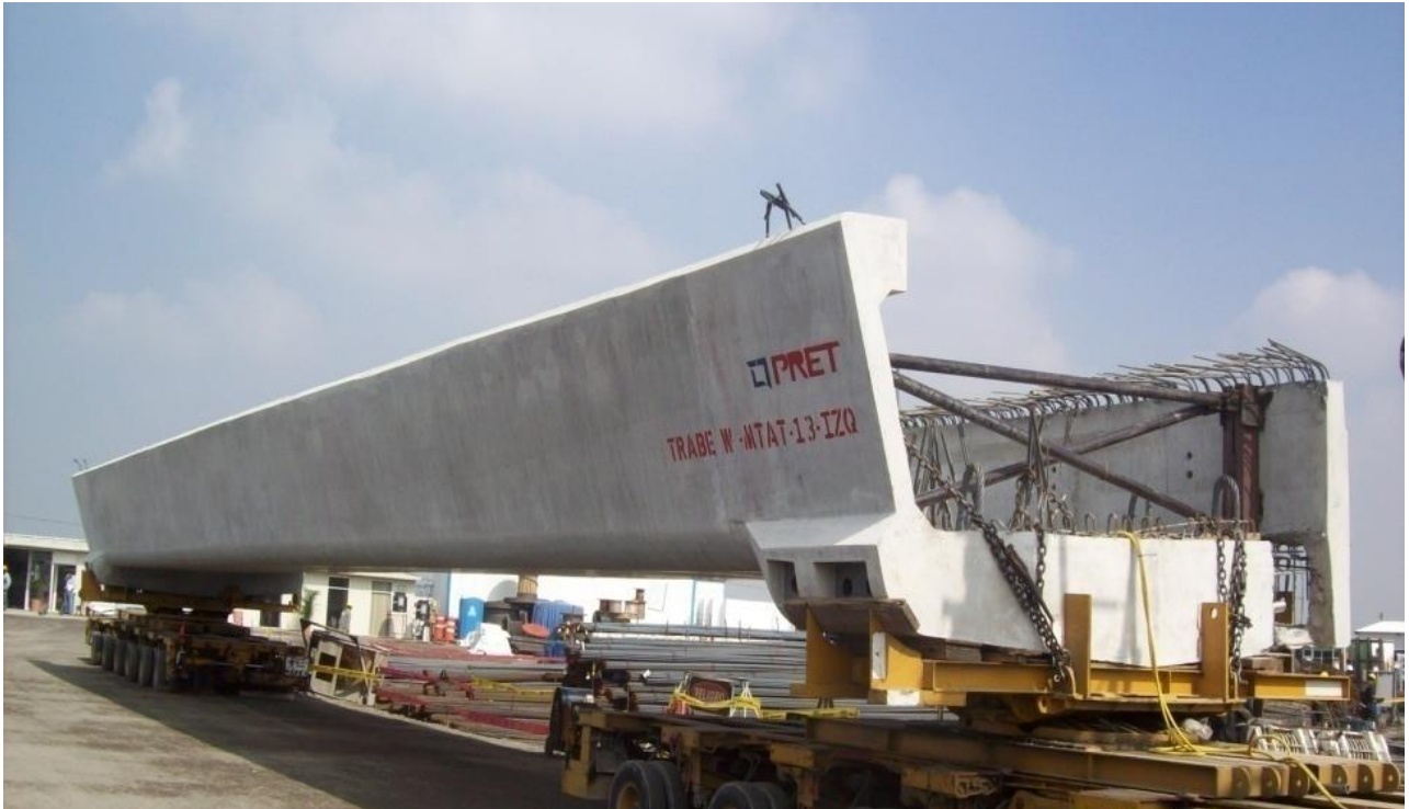
Figura IV.3.18.- Liberación de la trabe para su montaje. (Foto tomada por el autor)
