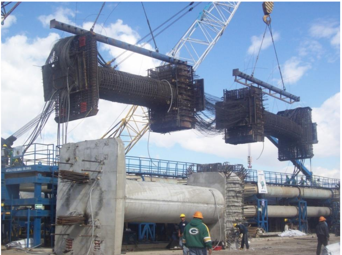
Figura IV.2.8.- Introducción del armado al molde (Foto tomada por el autor)
