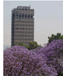
Torre Ejecutiva del IMP en SEDE. Fuente: IMP
