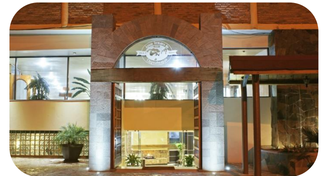
Acceso principal al edificio
