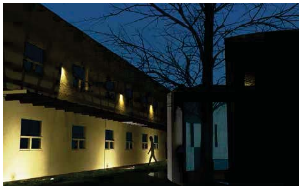
Imágen 20. Vista nocturna edificio de dormitorios
