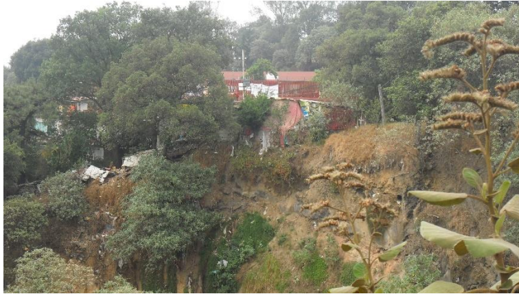
Figura 5.72. Fotografía A de la Zona 9, flanco oriente de la barranca. Sobre el talud se observa una vivienda que se encuentra en peligro por derrumbe.
