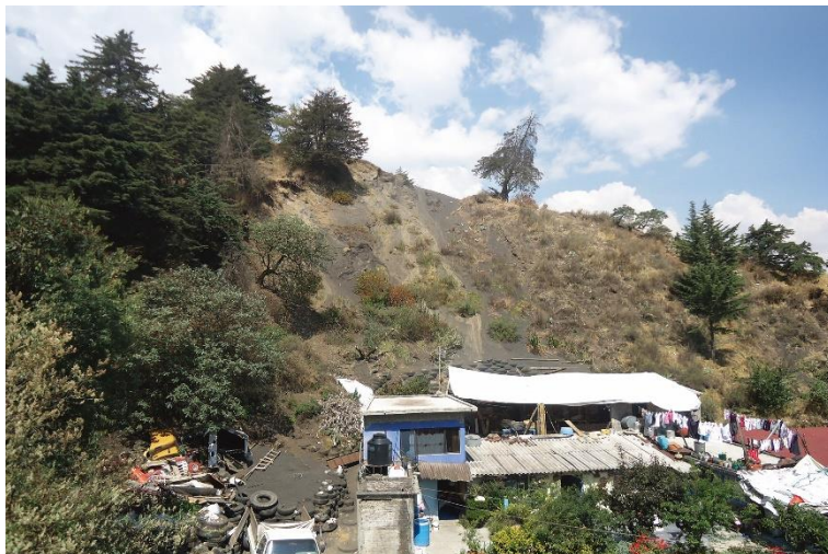
Figura 4.21. Fotografía L de la Zona 1, vivienda con problemas por deslizamiento. A espaldas de la vivienda, los propietarios, colocaron un muro de contención con llantas para evitar que el material desplazado llegue a la vivienda.
