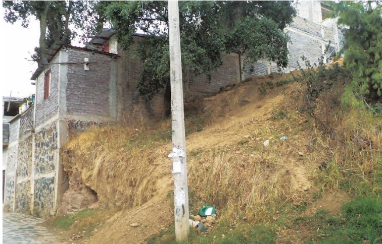
Figura 4.24. Fotografía A de la Zona 2, se aprecia el corte de la ladera para una calle y viviendas. Se marca la dirección del movimiento de los materiales y el depósito de los mismos sobre el camino en la parte inferior de la imagen.
