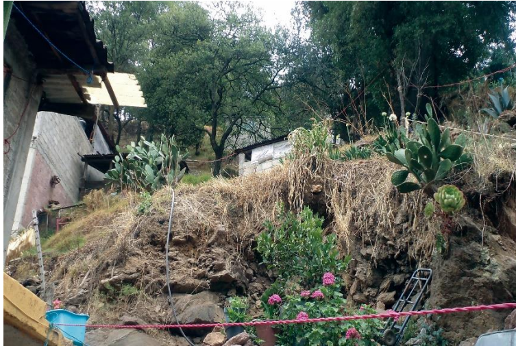
Figura 4.26. Fotografía C de la Zona 2, zona de posible derrumbe que representa un peligro tanto para las viviendas que se encuentran en la parte superior del escarpe como para las que se encuentran en la parte inferior.
