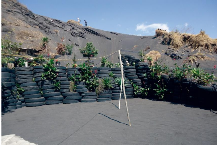
Figura 4.20. Fotografía K de la Zona 1, la falta de vegetación favorece la erosión y remoción de la ceniza volcánica del suelo, deslizamiento. El material desplazado por dicho fenómeno invade el patio de la vivienda, pese al muro de contención que ha sido levantado en varias ocasiones.
