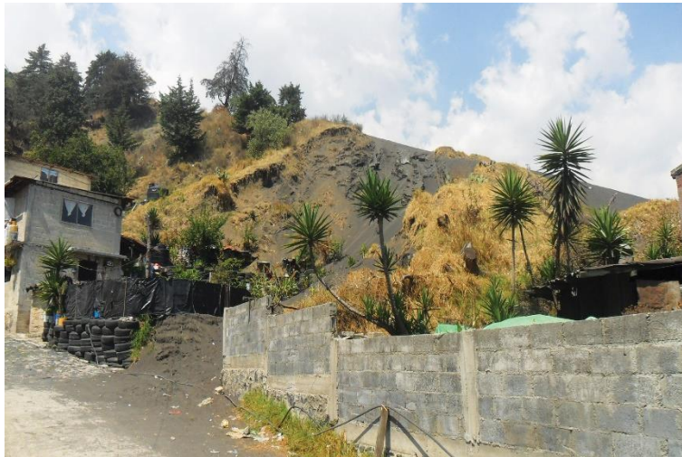
Figura 4.19. Fotografía J de la Zona 1, se aprecia el flanco derecho del deslizamiento en donde se puede observar la intensidad del proceso de deslizamiento en la ceniza. Las zonas sin vegetación muestran mayor actividad, en este caso se distinguen áreas con pastos que dan cierta estabilidad al material en los bordes de los escarpes.
