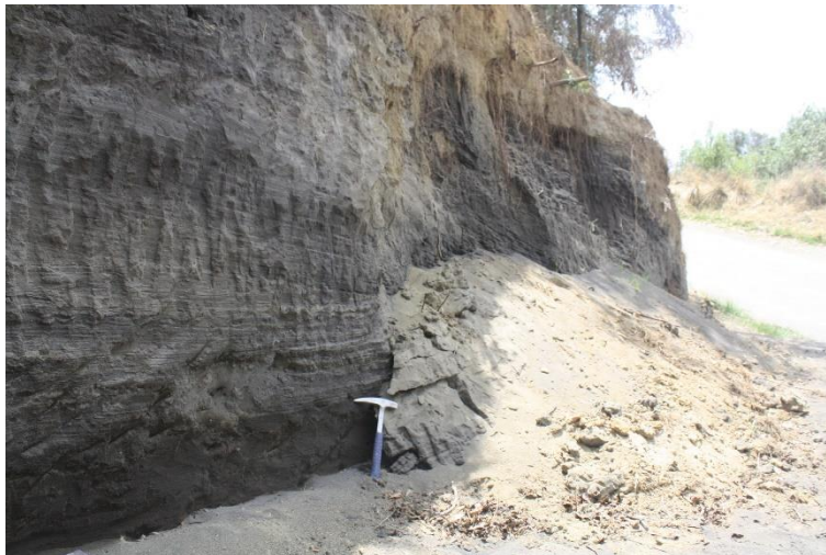
Figura 4.42. Fotografía D de la Zona 3, se muestra el derrumbe provocado por la poca compactación que tiene el depósito de ceniza.
