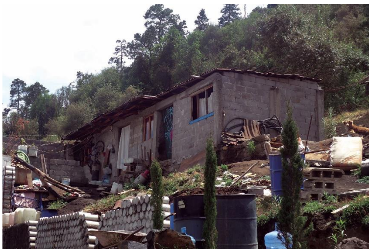
Figura 4.51. Fotografía C de la Zona 5, se muestra una vivienda construida sobre ceniza volcánica, frente a la vivienda hay muros de contención que mitigan el desplazamiento de material, a espala de la misma hay una pendiente con movimiento de material.
