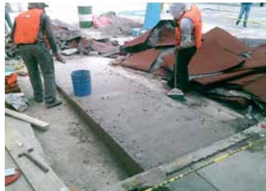
Vista del estado de deterioro de la impermeabilización de la azotea y trabajos de construcción de rampas de acceso. Fuente. INIFED.
