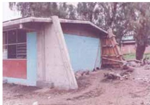
Refuerzo con contrafuertes en fachada lateral. Fuente: CAPFCE.Construyendo una nación. Informe de labores 1982-1988.
