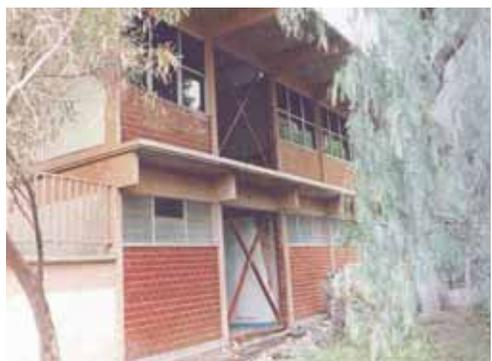
Rigidización de estructuras U-2 por medio de crucetas de acero. Fuente: CAPFCE. Construyendo una nación. Informe de labores 1982-1988.
